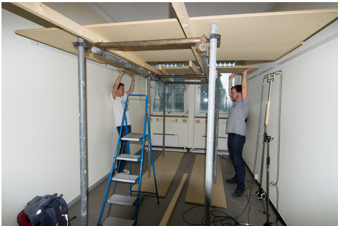
Figur 4.1: Sponplatene blir plassert oppå stilaset ved maksimal høyde
