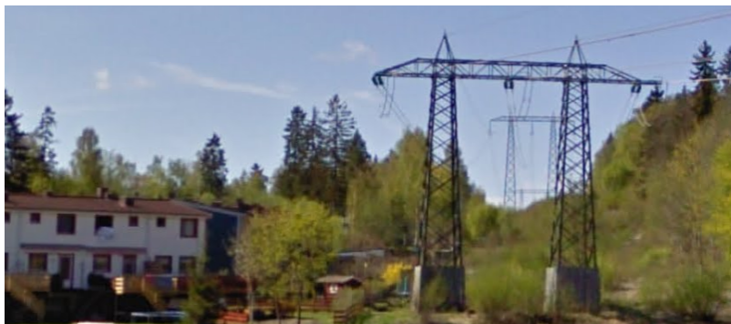
Figur 18: Kraftledning i ytterkant av verneområdet ved Dælivann (Google maps)
