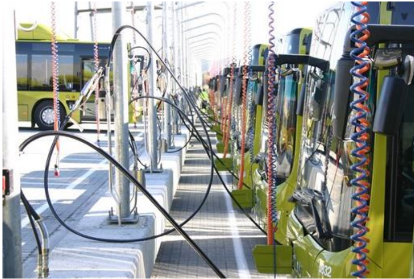
Figure 4.30 Sandmoen bus depot. Source: http://www.arkitektur.no/sandmoen-bussdepot .
