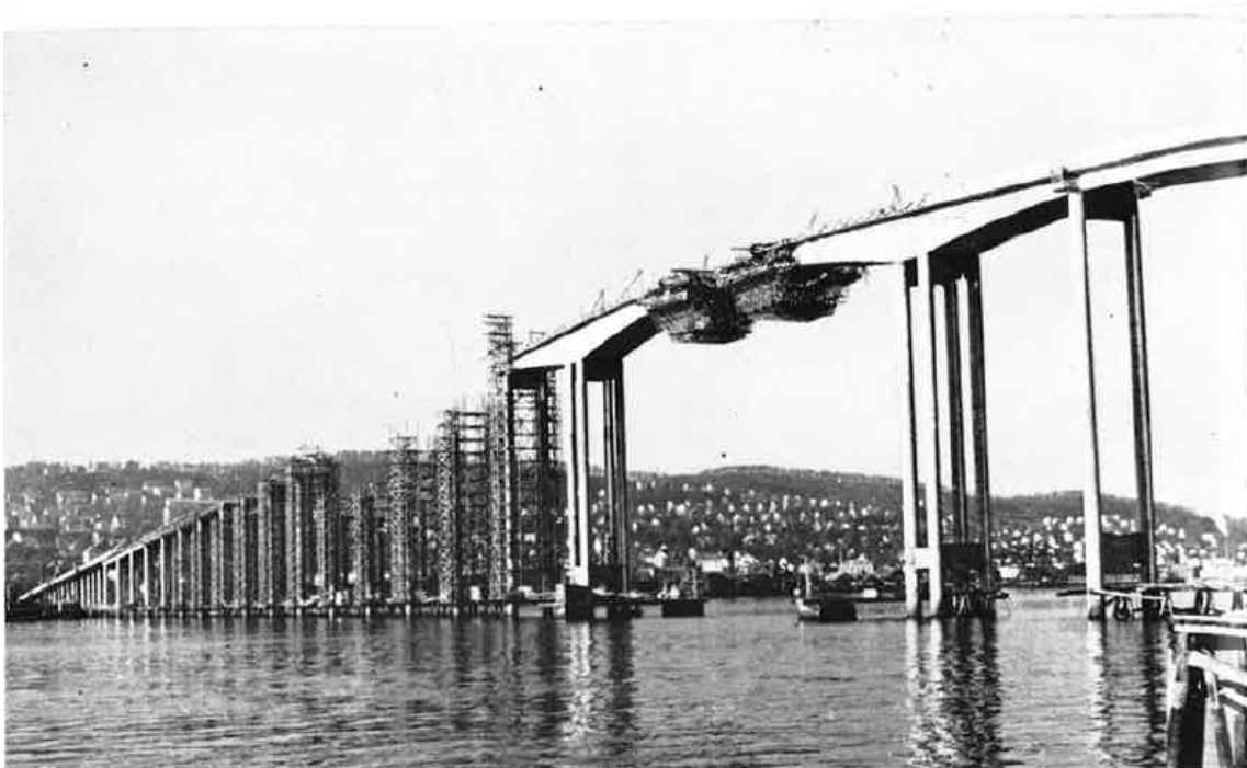
(a) Vognene møtes for sammenkobling av hovedspennet
