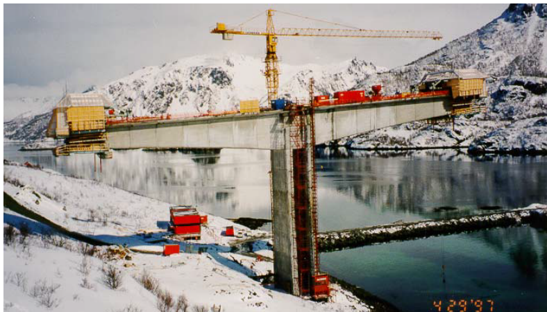
Figur 3.2: Balansert utbygging med forskalingsvogner [10]
