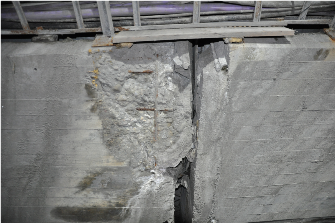
(a) Underside av dilatasjonsfuge mellom akse 7 og 8
