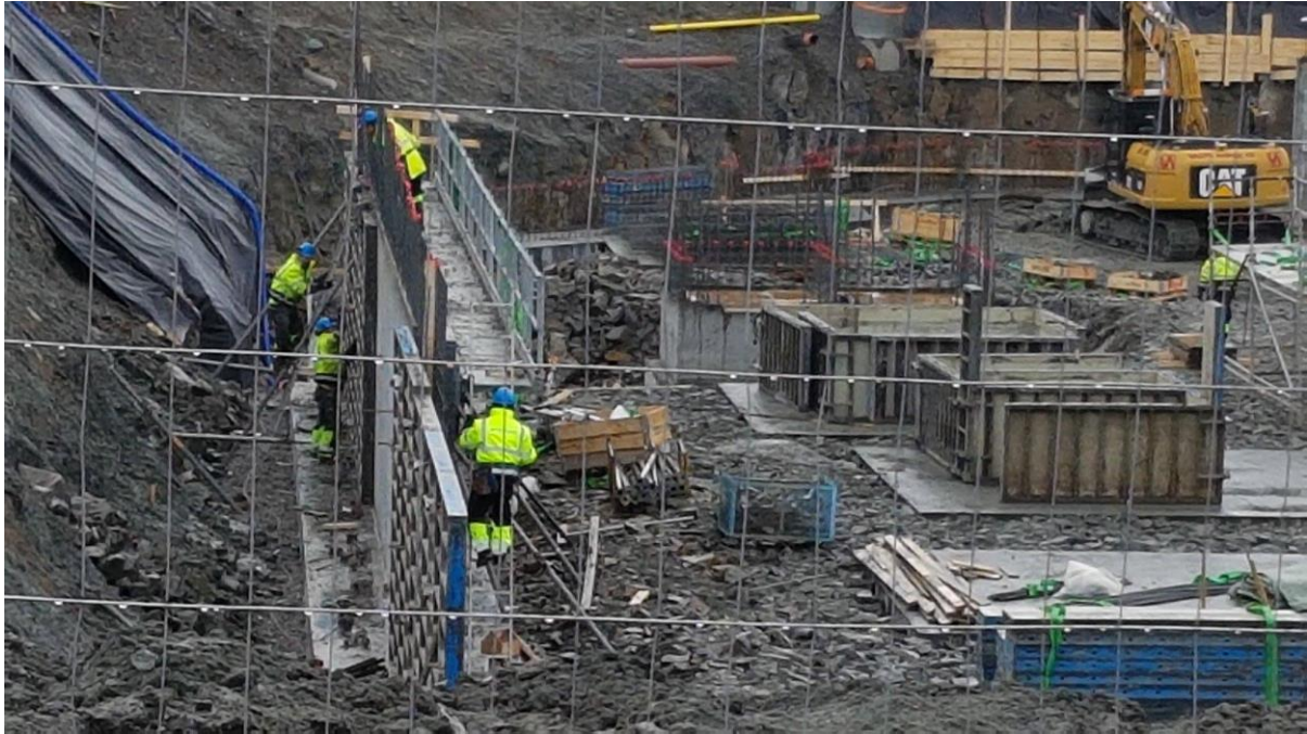
Figur 21: Viser forskalingsnekkere i arbeid
