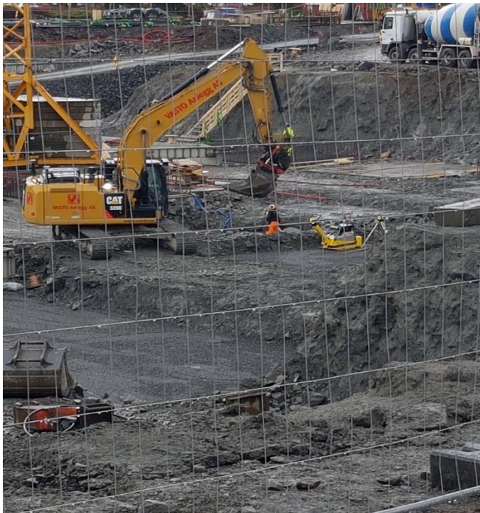
Figur 20: Gravearbeid utført ved gravemaskin
