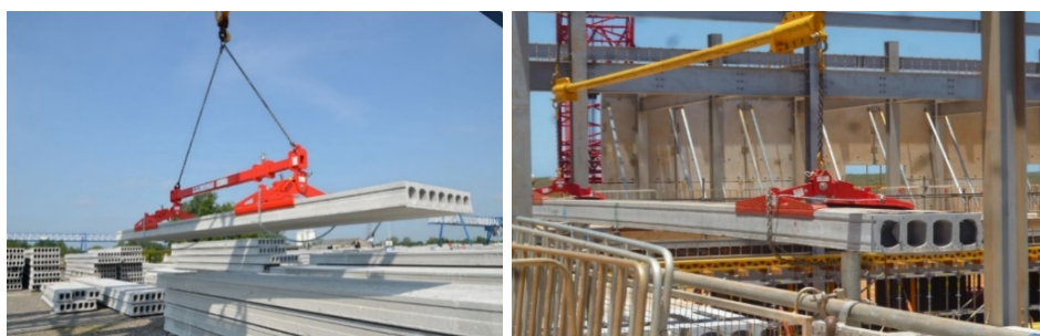
Figur 15: Løfting av hulldekker (Spirall)
