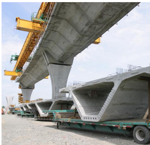
Figur 2.5.2-1- Elementbru.
