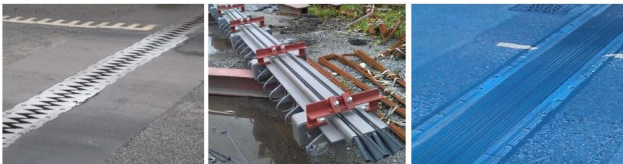
Figur 2.4.4-1- (F.v) Fingerfuge, flerelementfuge og mattefuge.
