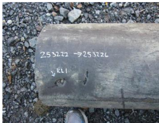
Figur 2-4: Bildet viser sprekkvekst som er tatt i Oslo vannverk
