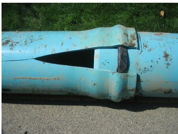
Figur 2-3: Sprekkvekst, bildet fra UC underground construction
