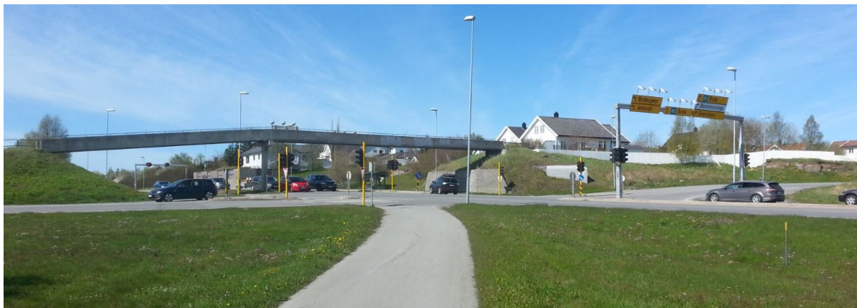
Figur 3.1: Bilde av Grønnåsenkrysset tatt på befarig
