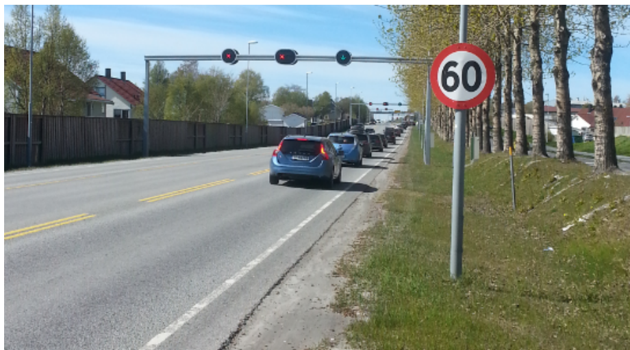
Figur 3.3: Bilde av kjørefeltsreguleringen på 3-feltsvegen tatt på befaring
