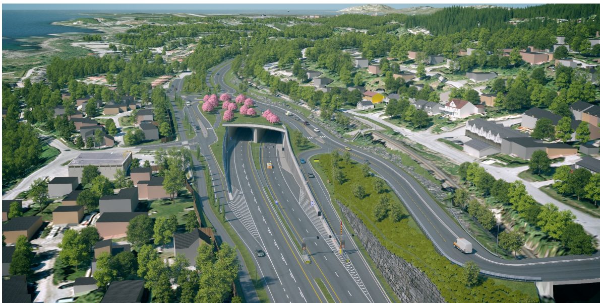
Figur 4.4: Hunstadkrysset etter tunnelåpning, (Bypakke, 2017)
