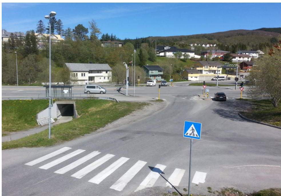
Figur 3.2: Bilde av Stille Dal krysset tatt på befarig
