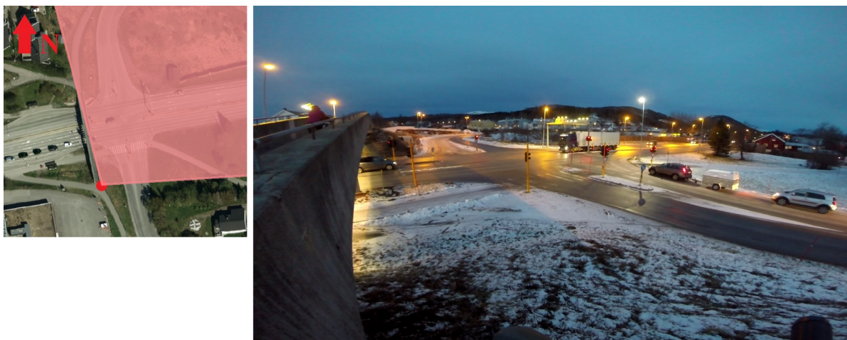
Figur 3.5: Kameraplassering i Grønnåsenkrysset, (venstre bilde bruker et ortofoto fra vegkart.no (Vegvesen, 2016c) og redigert, høyre bilde er fra befarings)
