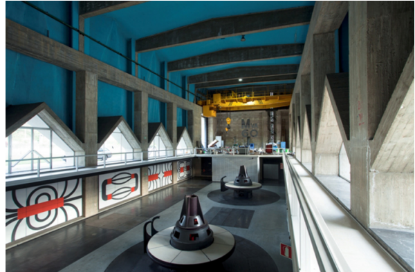
Figur 8.26: Proaza Hydroelectric Power Plant, av Joaquim Vaquero Palacios, 1965. Bilde til høyre viser bygningens hovedrom. De runde formene som stikker opp fra gulvet er hodene på kraftverkets generatorer. Den spesielle veggkunsten skal ikke bare være fin å se på, men også illustre hvordan magnetisme virker [14, b].
