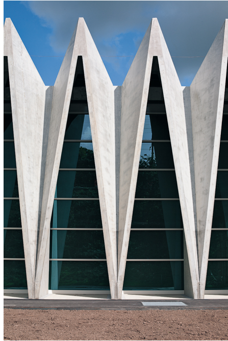
Figur 9.3: I veggene er det brukt innsnevrede veggelement som i Kongsberg kino [16,b].
