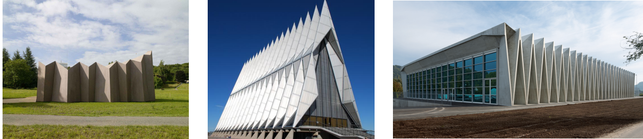
Figur 2.1: Eksempler på foldede konstruksjoner i tre, metall og betong. Fra venstre: The chapel of St.Loup (2008) Epfl Ibois and Localarchitecture [1, b], United States Air Force Academy Cadet Chapel (1962) Walter Netsch [2, b], Mülimatt Sports Education and Training Centre (2010) Studio Vacchini Architetti [3, b].
