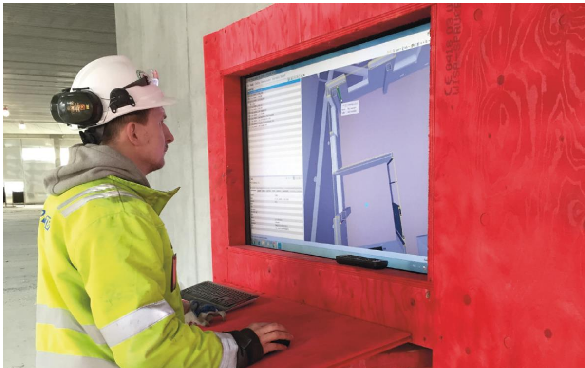
Figur D.4: Arbeid med BIM-kiosk (Foto: Snøhetta, Holm, 2016)
