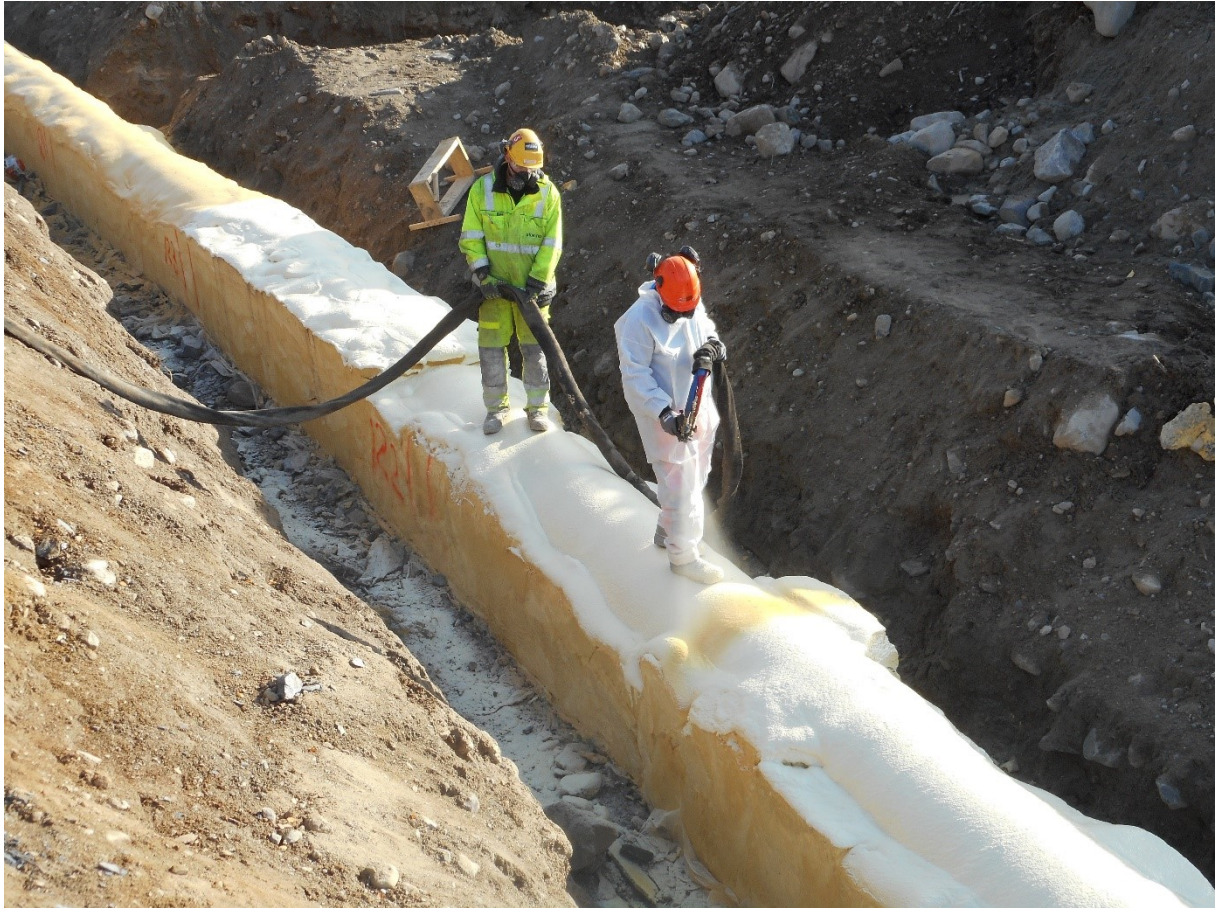
Figur 9 Påføring av sprøyteskum på områder som manglet omfylling
