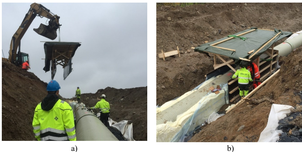
Figur 20 a) Forskalingen løftes b) Forskalingen er plassert rundt røret
