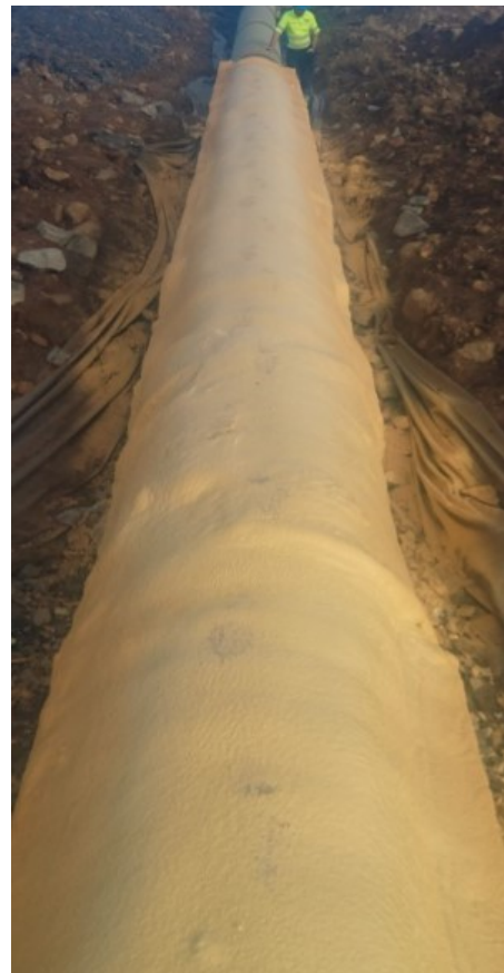
Figur 4 Rettstrekke i rørgata
