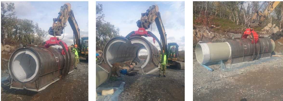
Figur 22 a) Lukket form b) Forma åpnes c) Forma festes rundt røret
