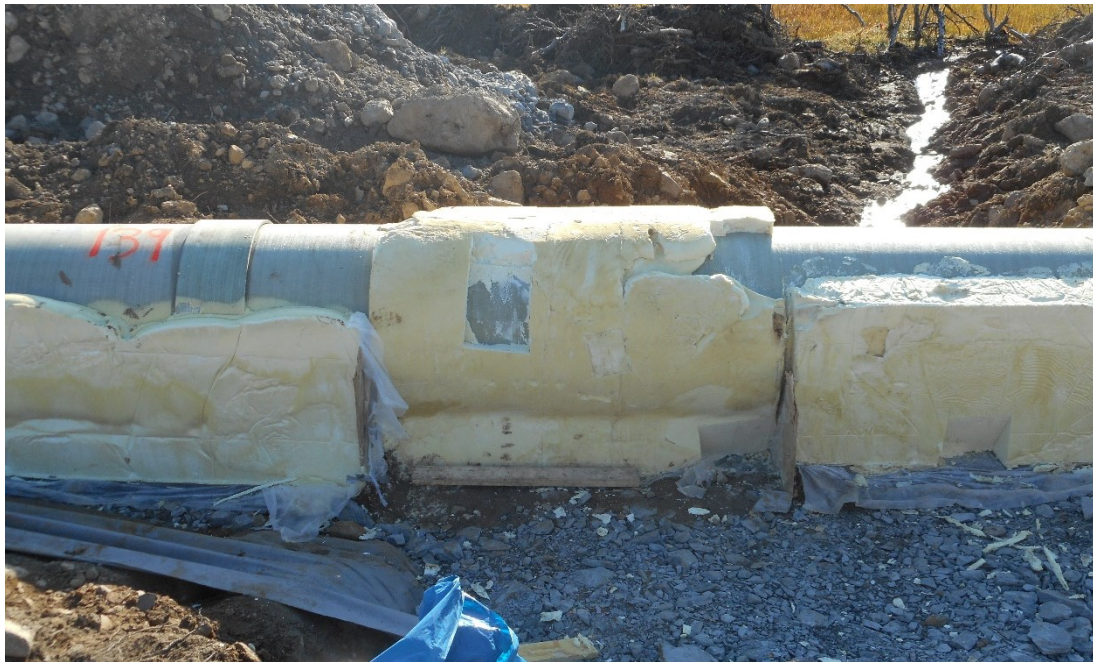
Figur 11 Resulterende skumtværsnitt ved bruk av lukket forskaling
