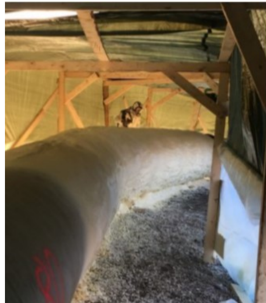
Figur 8 Påføring av sprøyteskum innendørs
