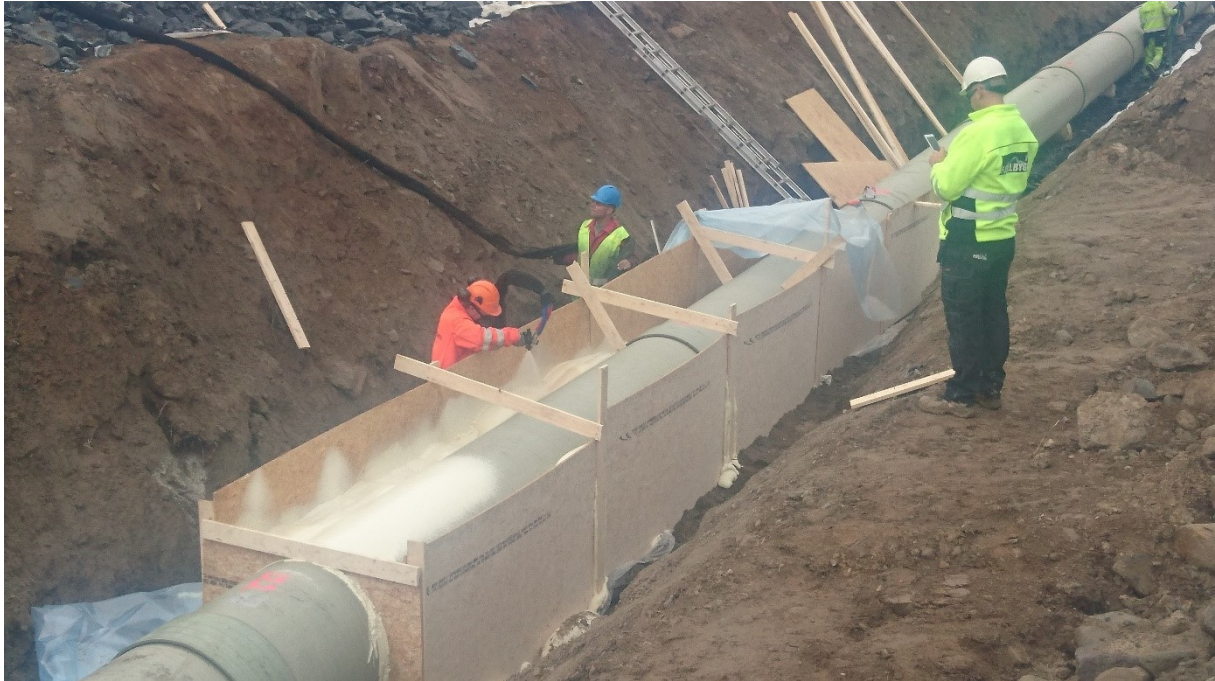
Figur 6 Påføring av skum med bruk av enkel forskalingsmetode
