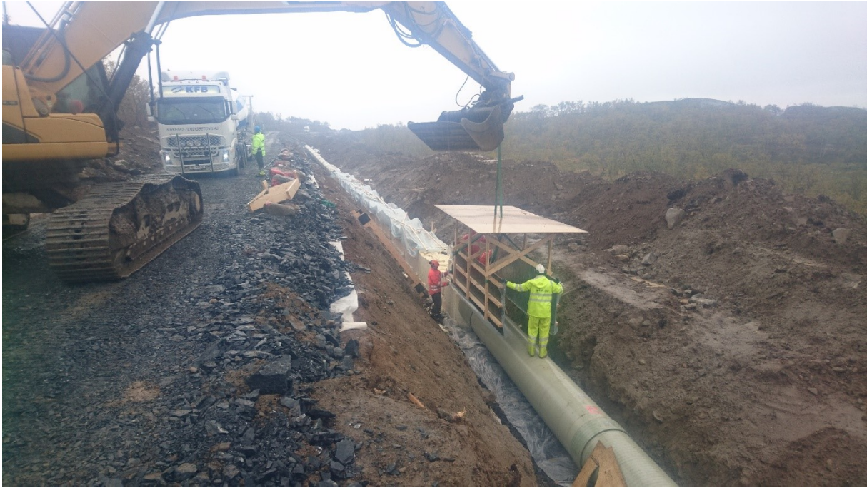
Figur 7 Videreutviklet forskalingsmetode med tak og løfteanordning
