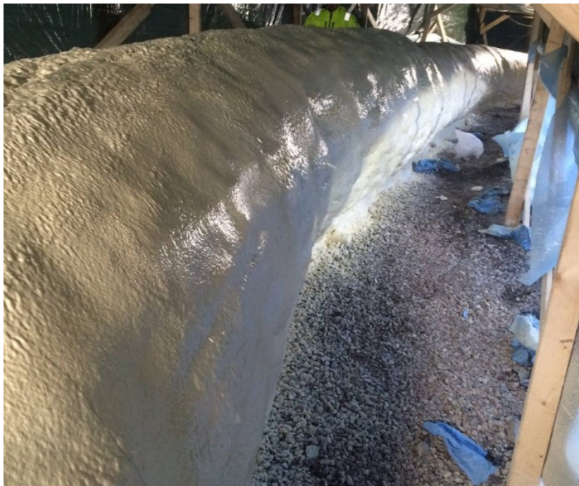
Figur 3 Eksempel på skumlagt bend
