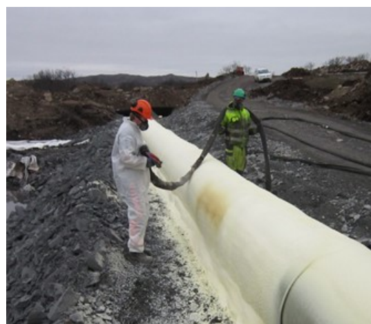
Figur 24 Påføring av sprøyteskum direkte på rør
