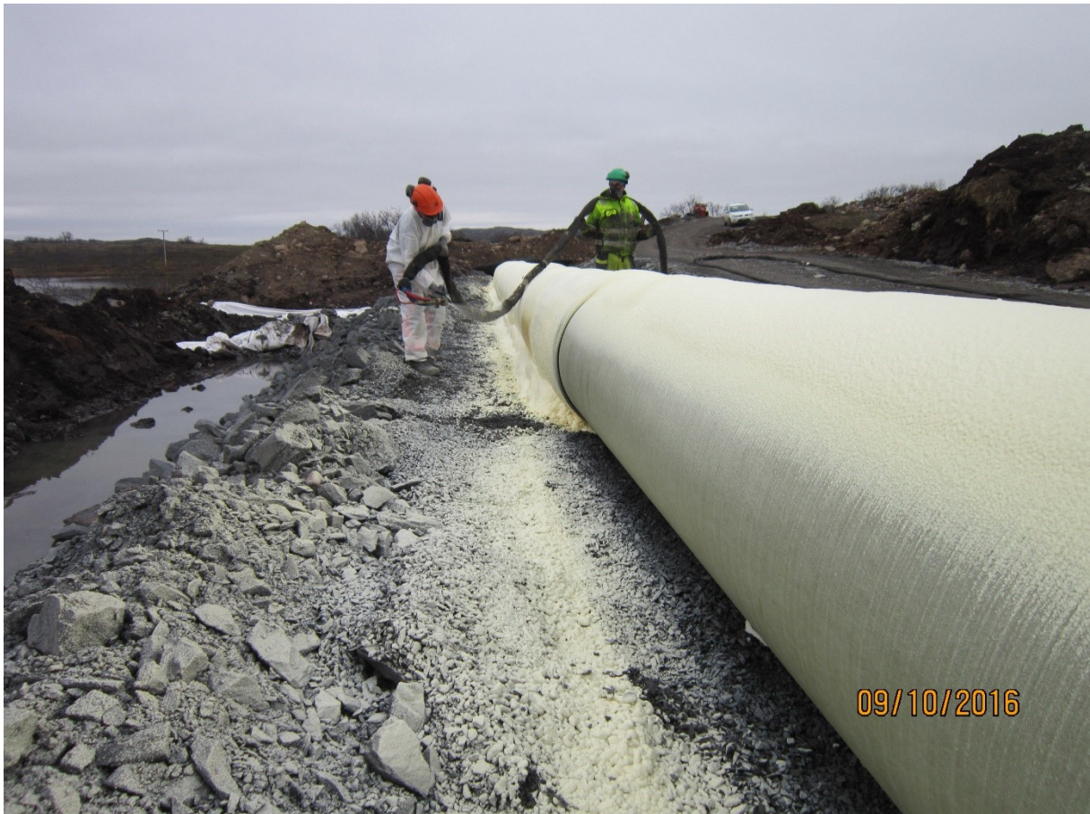
Figur 12 To personer ansvarlig for påføring direkte på rør
