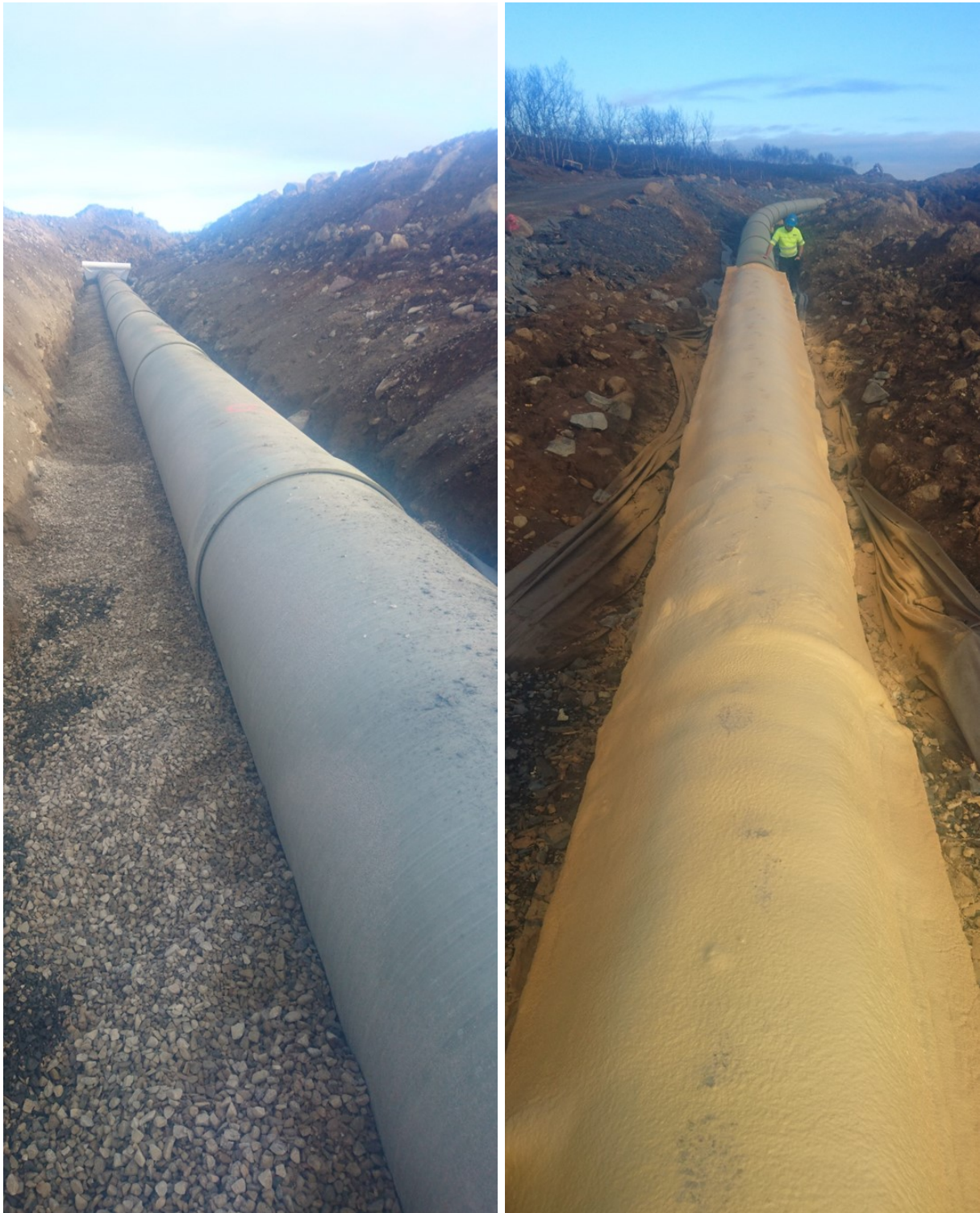
Figur 14 Rettstrekke lagt med PU-skum som omfyllingsmasse
