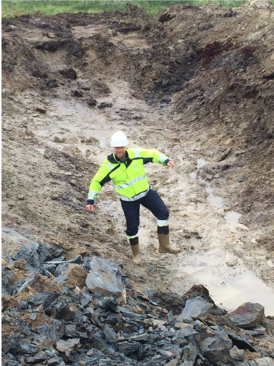
Figur 2 Grøftebunnen inneholdt ikke stabile masser
