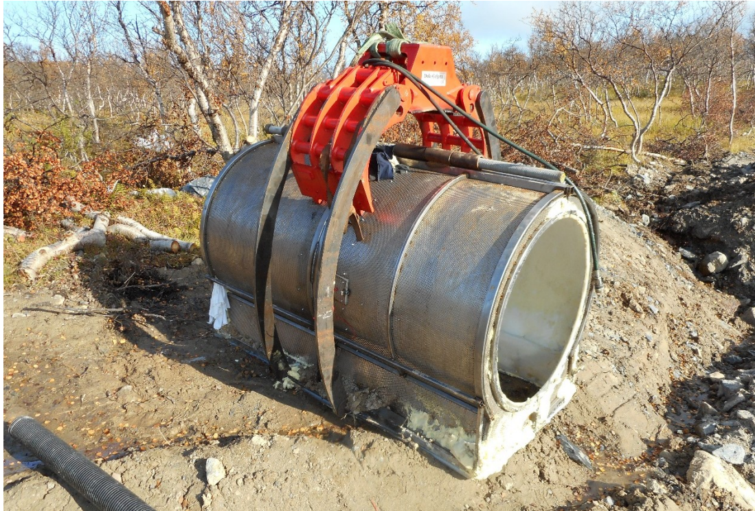
Figur 10 "Klo" benyttet som lukket forskaling
