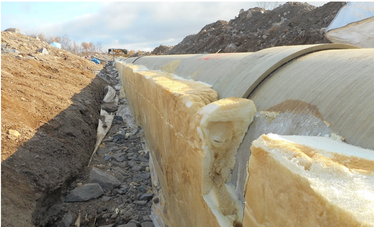
Figur 8 Resulterende skumtværnsnitt når forskalingen ble fjernet
