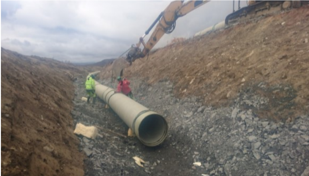
Figur 9 Grøftetverrsnitt med drenerende masser i bunn
