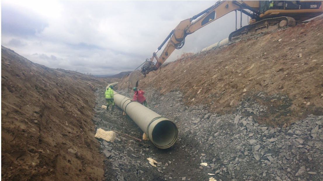
Figur 3 Legging av GRP-rør
