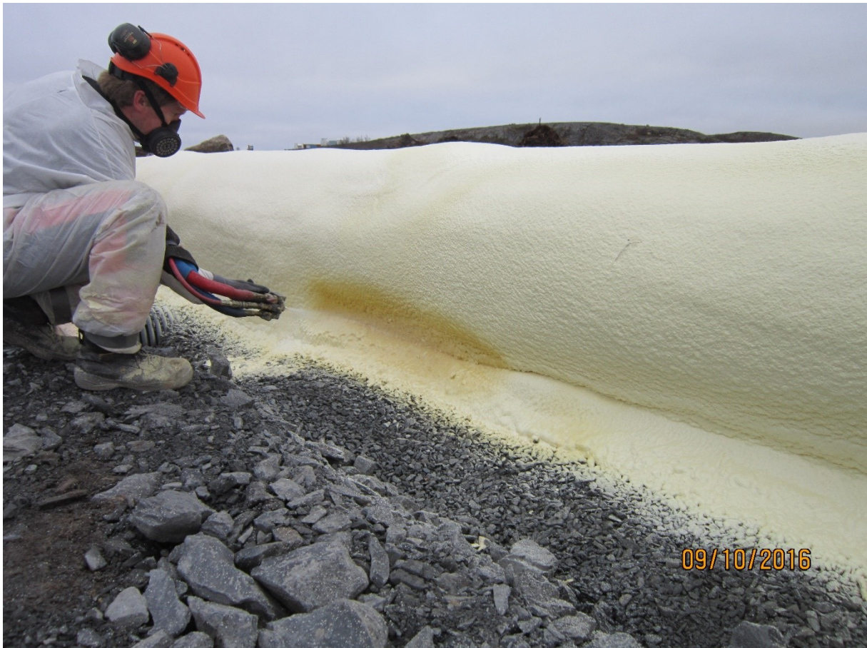
Figur 13 Påføring direkte på rør med bruk av sprøyteskum
