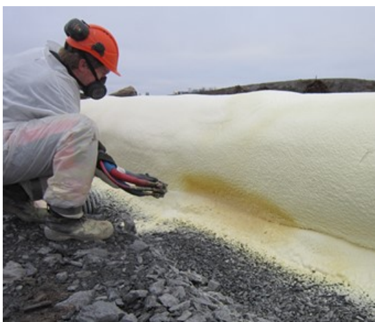
Figur 24 Påføring av sprøyteskum direkte på rør
