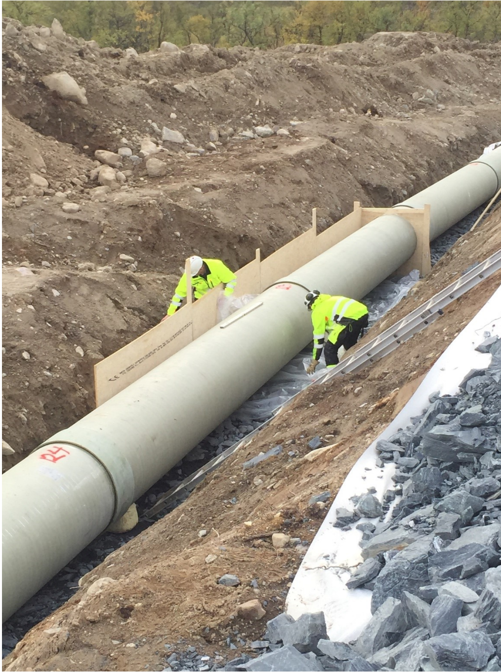
Figur 5 Bygging av enkel forskalingsløsning
