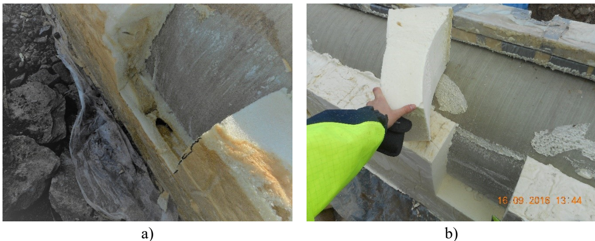
Figur 26 Skum påført med ulik temperatur på komponentene a) Temp. 25\text{ }^{\circ}\text{C} b) Temp. 45\text{ }^{\circ}\text{C}
