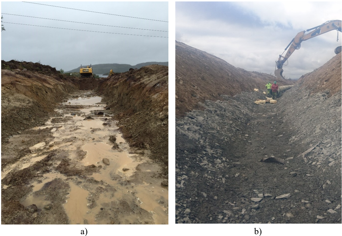
Figur 18 Situasjonen i grøftebunnen a) Før tiltak b) Etter tiltak
