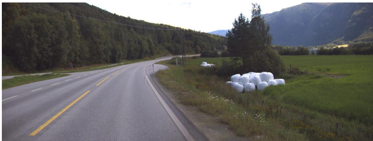
Figur 6.15: Helning ned mot veien på venstre side, ingen helning på høyre side
