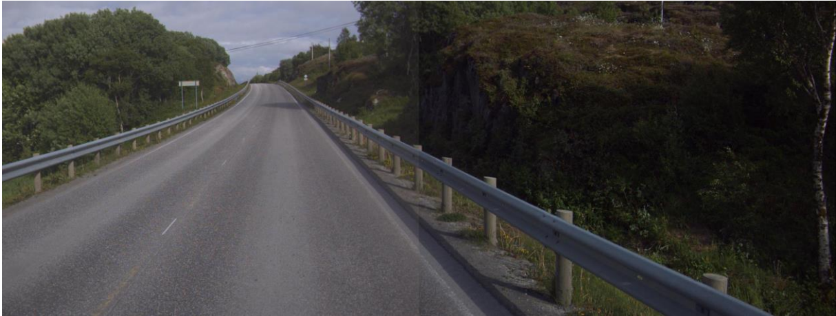
Figur 6.6: Enkelt Rekkverk på begge sider
