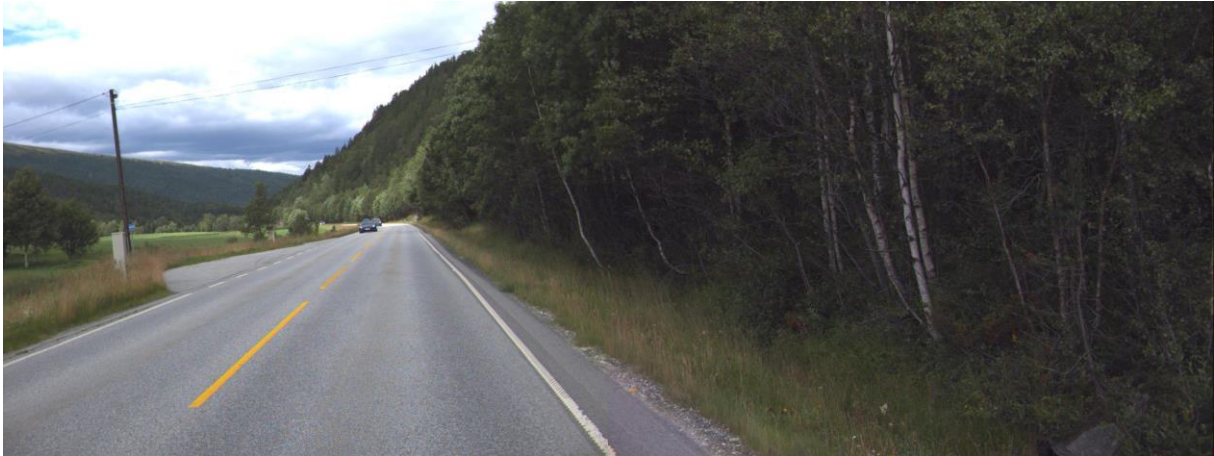
Figur 6.10: Trær tett opptil veien kun på en side
