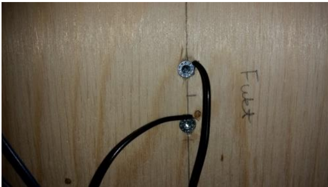
Figur 46. Elektroder (skruer) med kopperledning for å muliggjøre registrering av fuktinnhold fra boksens utside.
