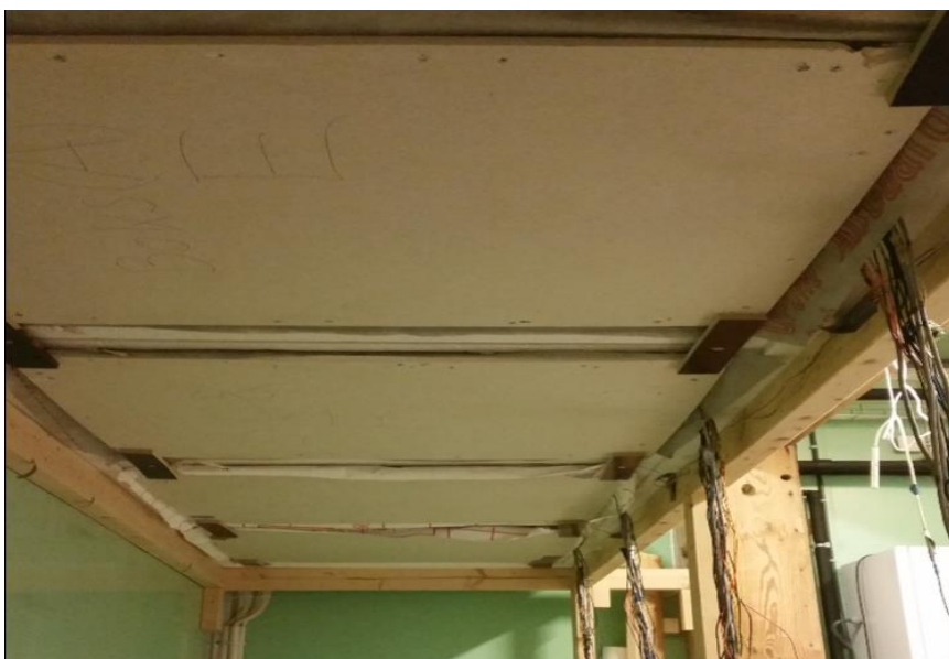
Figur 28. Takriggens underside med fire prøvebokser montert.
