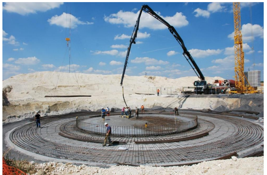
Gravitasjonsfundament under konstruksjon (NORWEA, VindkraftensABC, side 15).
