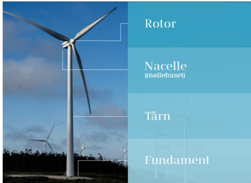
Hovedkomponenter i en vindmølle
