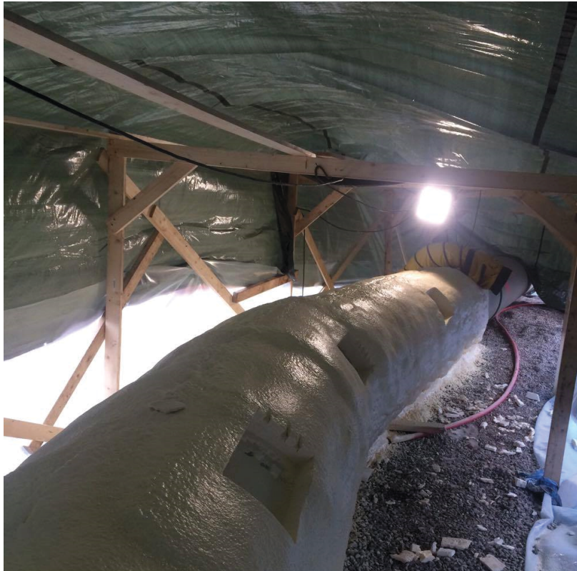
Figur 51: Eksempel på metode for oppvarming av rør; overbygd telt og varmluft fra kokoverk
