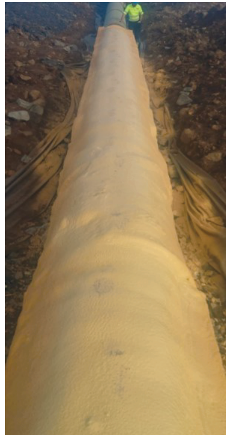
Figur 4 Rettstrekke i rørgata
