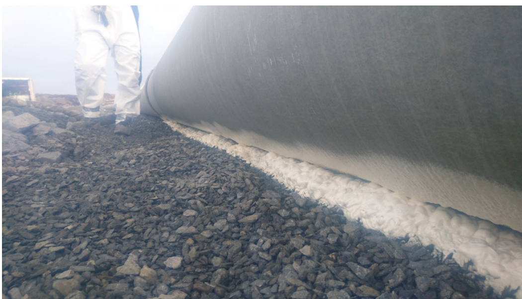
Figur 50: Grensesjikt mellom skum og pukk under rørgata
