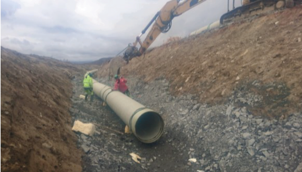
Figur 9 Grøftetverrsnitt med drenerende masser i bunn
