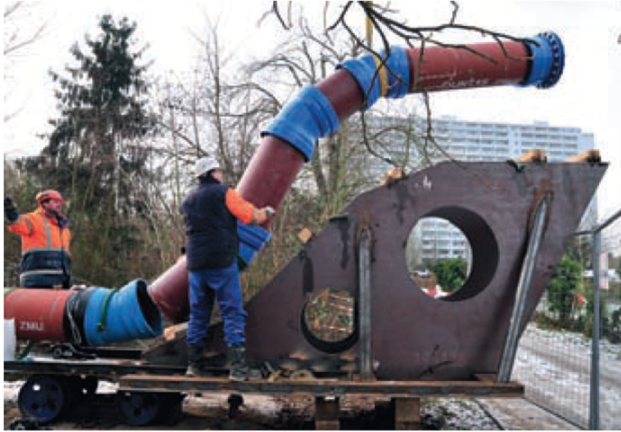
Figur 5: Strekkfaste bend med duktile støpejernsrør (Duktus, u.d.)
