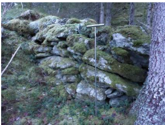
Figur 25: "Intakt" mur på Vinillen. Jordborr er ca. 1,1 m. Mot. SØ. Foto: VH.
