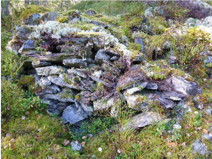
Figur 22: Den SØ-del av muren finner vi "inntakt" del av muren. Tomstokk er 20 cm. Mot: NV. Foto: VH.
