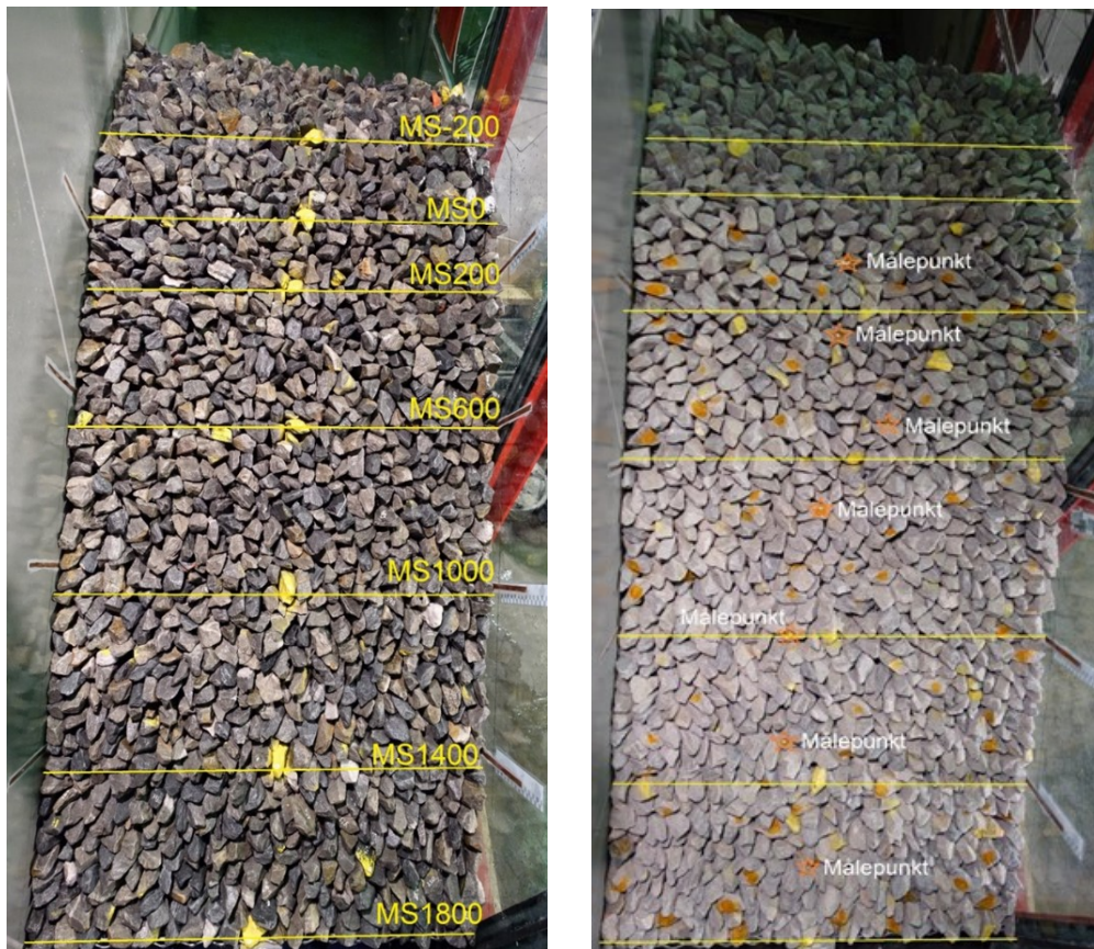
Figur 13 – t.v ferdigbygget plastring med markørsteine, t.h målepunkt med b-akse inn
