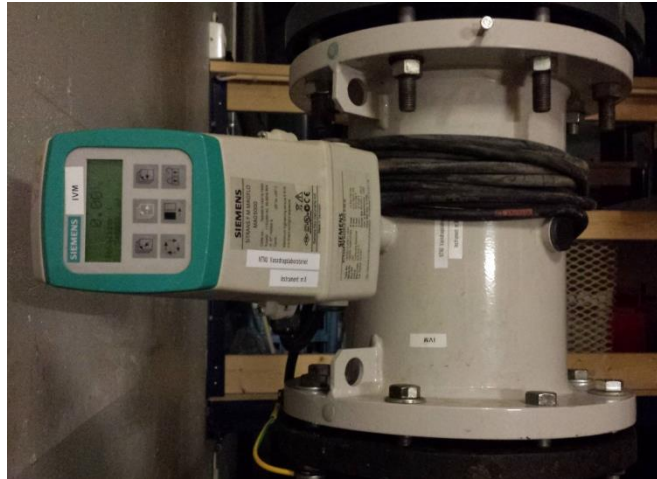
Figur 4-13 Vannføringsmåler
