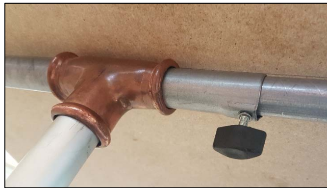
Figur 21 - Justeringsløsningen med t-stykke
