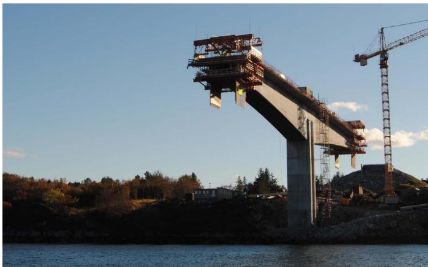
Figur 3-7: Balansert utbygging med forskalingsvogner fra Akse 2 på Dolmsundbrua [14]
