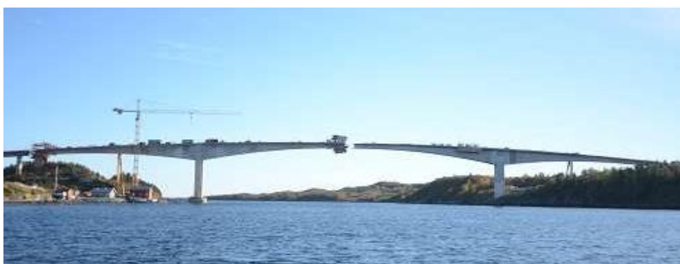
Figur 3-8: Dolmsundbrua like før støpning av koblingsseksjon [15]
