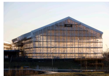
Figur 8: Værbeskyttelse fra Ramirent(Ramirent, 2016).
