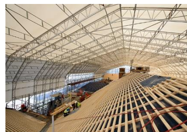
Figur 3: Værbeskyttelse levert av HAKI(HAKI AB, 2015).
