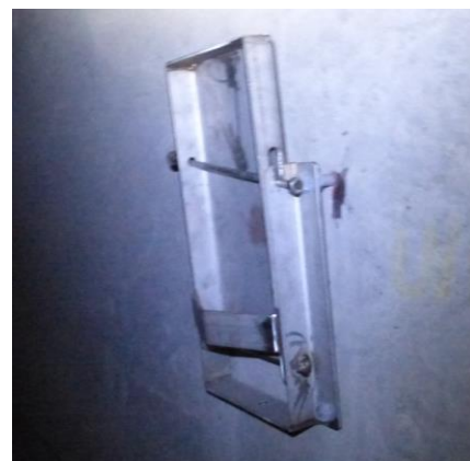
Figur 3.3: Ny type tunellmerke i oppslått stilling (Gihlemoen, 2015b)
