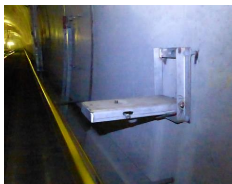
Figur 3.2: Ny type tunellmerke i nedslått stilling (Gihlemoen, 2015a)
