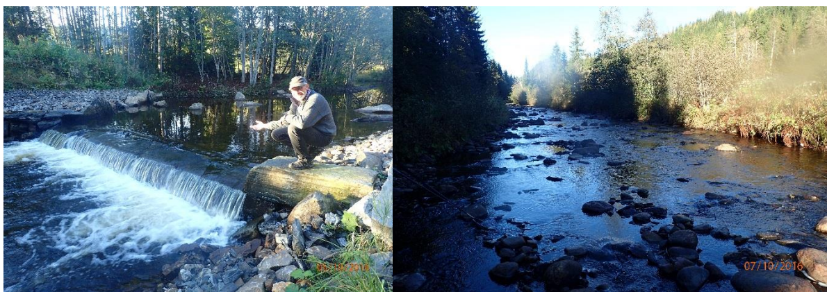
Bildeserie 5. Terskelen/sperra mot oppgang av gjedde og ørekyt i Tømra, og bilde av elveparti i Tømra, oktober 2016.
