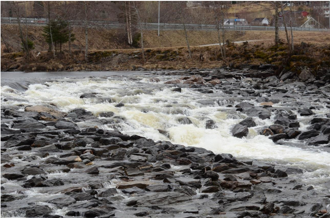
D: Øvre del av terskelen i Garbergelva.
