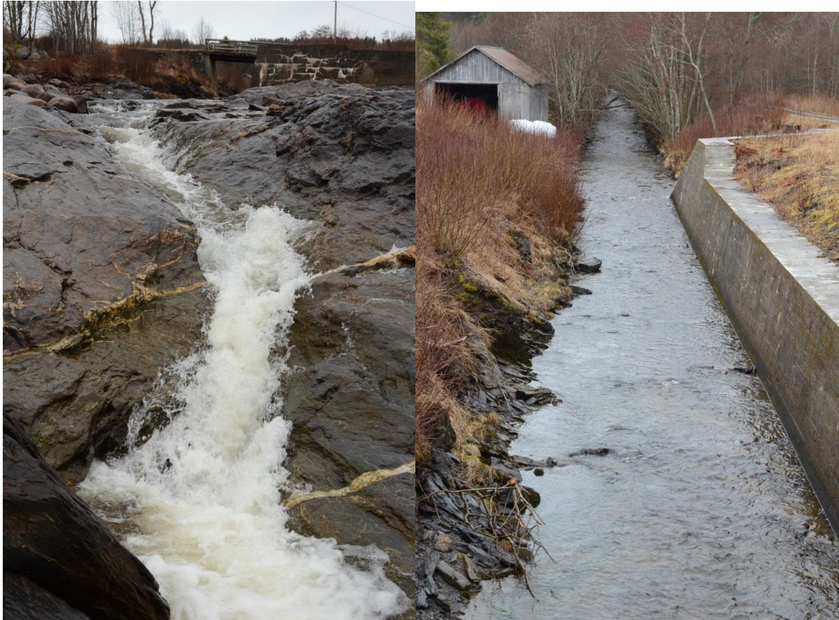
E: Grøttemselvas utløp i Selbusjøen (reguleringssona, venstre) og kanalisert nedre del av Grøttemselva (høyre).
