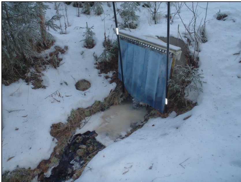
Figur 8. Farget is ved utløp av stikkrenne Ø3 ved Osensjøen.
