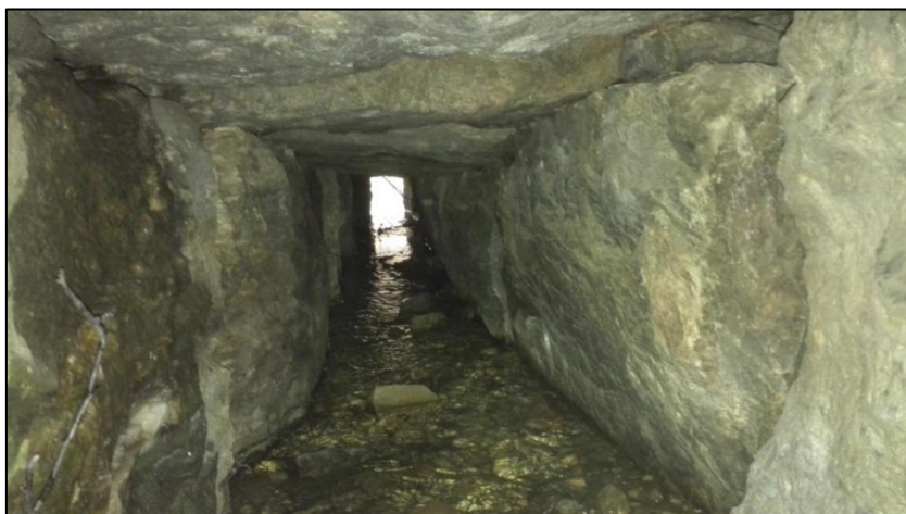
Figur 37. Innover stikkrenne D3 fra innløp mot utløp. Oppmurte, firkantede stikkrenner
