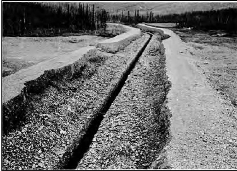
Figur 10. Bildet viser en en smal dyp kanal for vintervannføring, i Alaska 1968. Kanalveggene er laget av steinfylte gabionnett. Bilde hentet fra Carey (1973)
