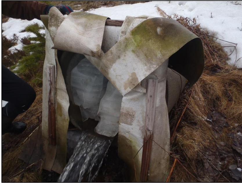
Figur 87. Observert isdannelse i utløp på stikkrenne Ø1.
