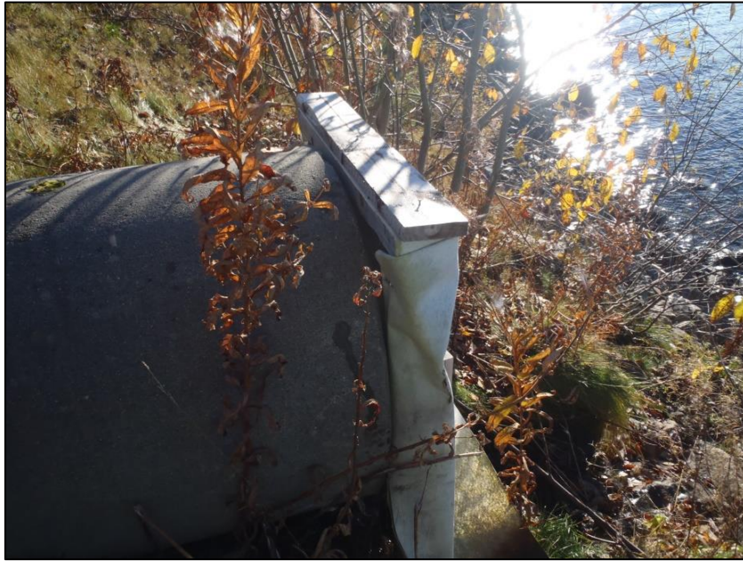
Figur 13. Fiberduken er også festet på siden, rundt selve rammen. Fra utløp på stikkrenne Ø1.
