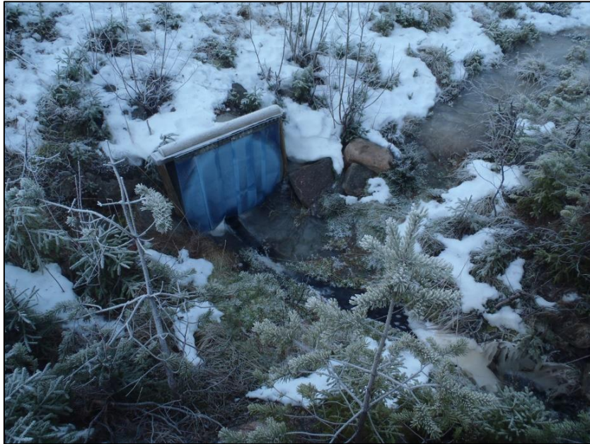
Figur 30. Innløp Ø3, med nytt kuldeskjørt av plaststrimler.
