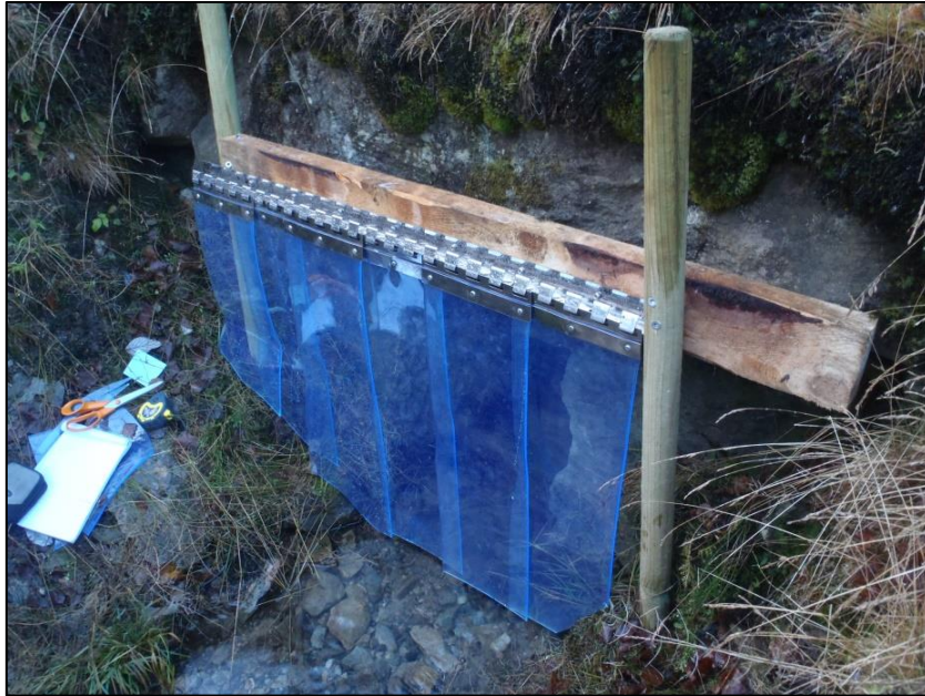
Figur 14. Plaststrimler over utløp til stikkrenne D2 i Dovre. Lengdene er tilpasset terrenget. Enkle verktøy som målebånd og saks i bruk. Festeskinnen og platene gjør det enkelt å fjerne strimlene i perioder, og sette dem på igjen
