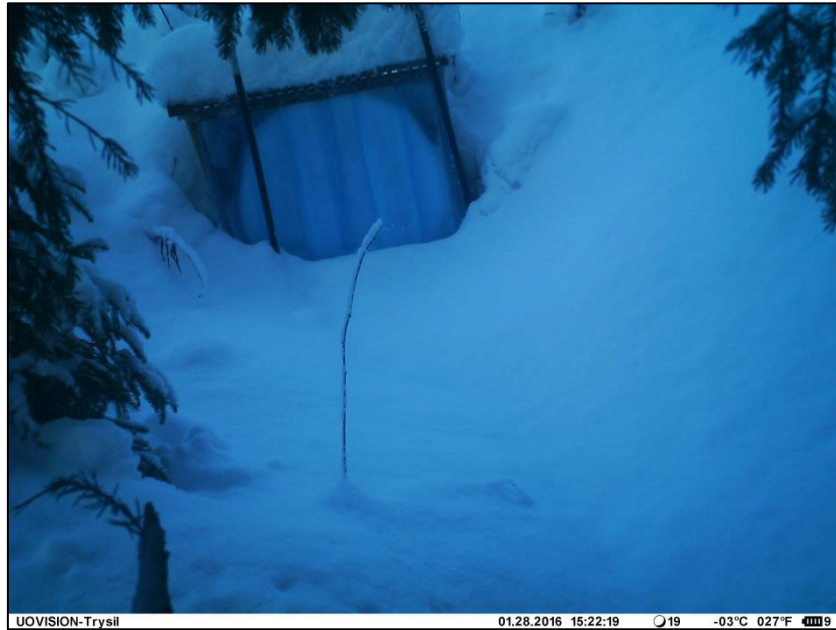
Figur 72. Bildet fra 28.01.16 viser at det fortsatt er dogg på plasten.
