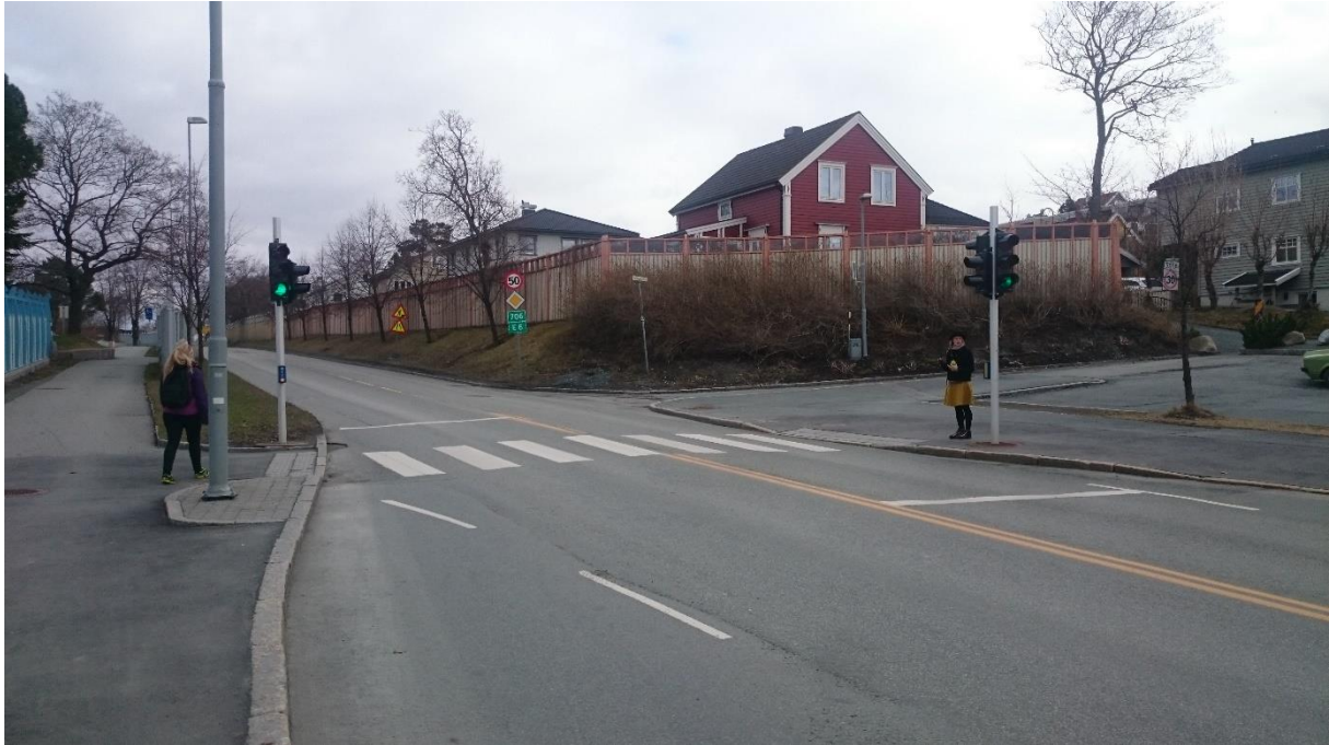
Figur 4.24: Fotgjengerovergang med signalregulering ved Saxenborg allé.
