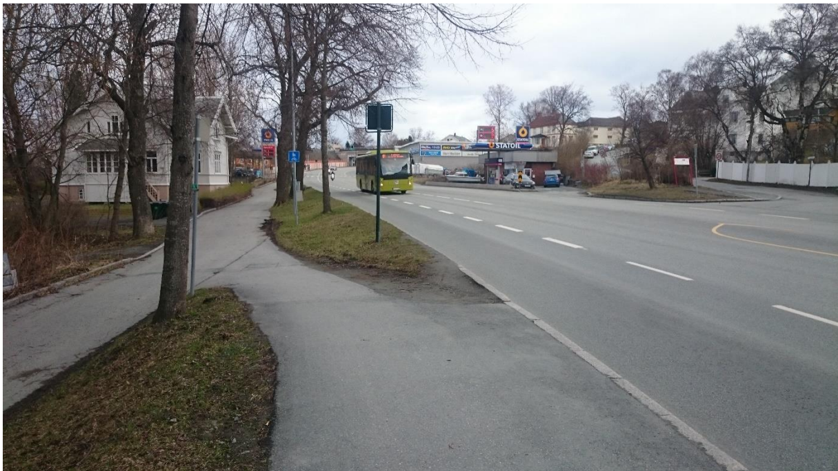
Figur 4.23: Vegen østover fra Thomas Von Westens gate og mot Rønningsbakken.
