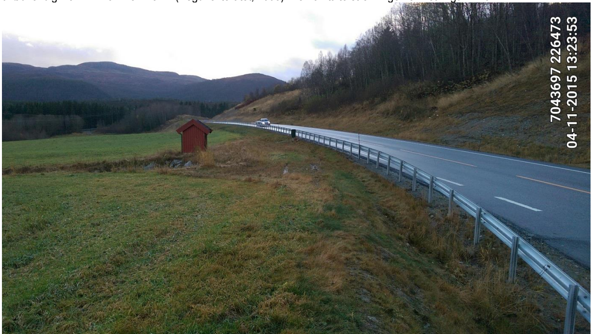
Figur 52: Bildet er tatt fra ca. profil 25150 i retning Krokstadøra (økende profilnr.). Det røde huset er en pumpestasjon.
