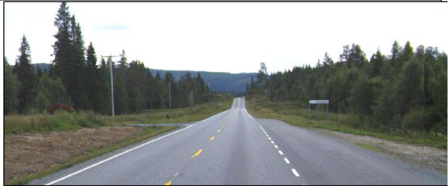
Figur 15: Bilde fra E14 fra Meråker mot Storlien. Rettlinje blir avsluttet med en bakke (stigende vertikalkurvatur) uten kurvepunkt i horisontalkurvaturen. Kilde: NVDB
