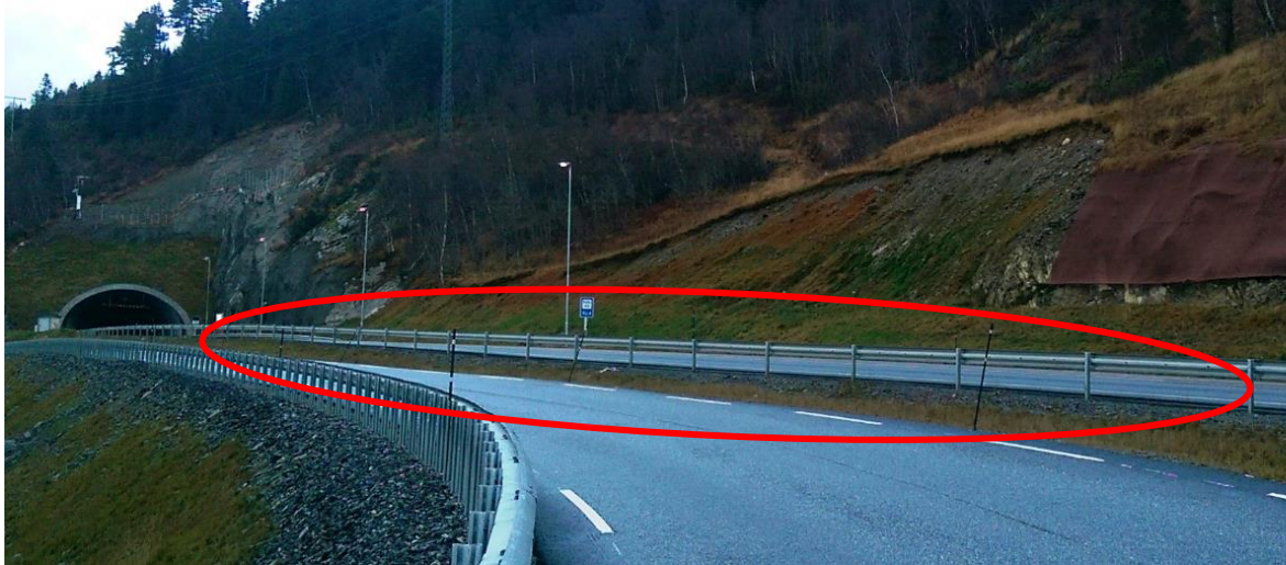
Figur 26: Viser Harangstunnelen med portalområdet på Harangen. Bildet er tatt ifra lokalvegen og viser at det ikke er benyttet tett rekkverk som anbefalt.
