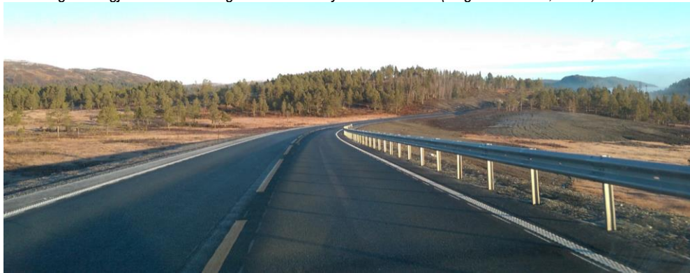
Figur 42: E39 sett fra ca. profil 12900 i retning Harangen (ved Damtjønna). Rekkverket kunne vært vurdert avsluttet tidligere på sørsiden av vegen, dette blir høyre side på bildet.
