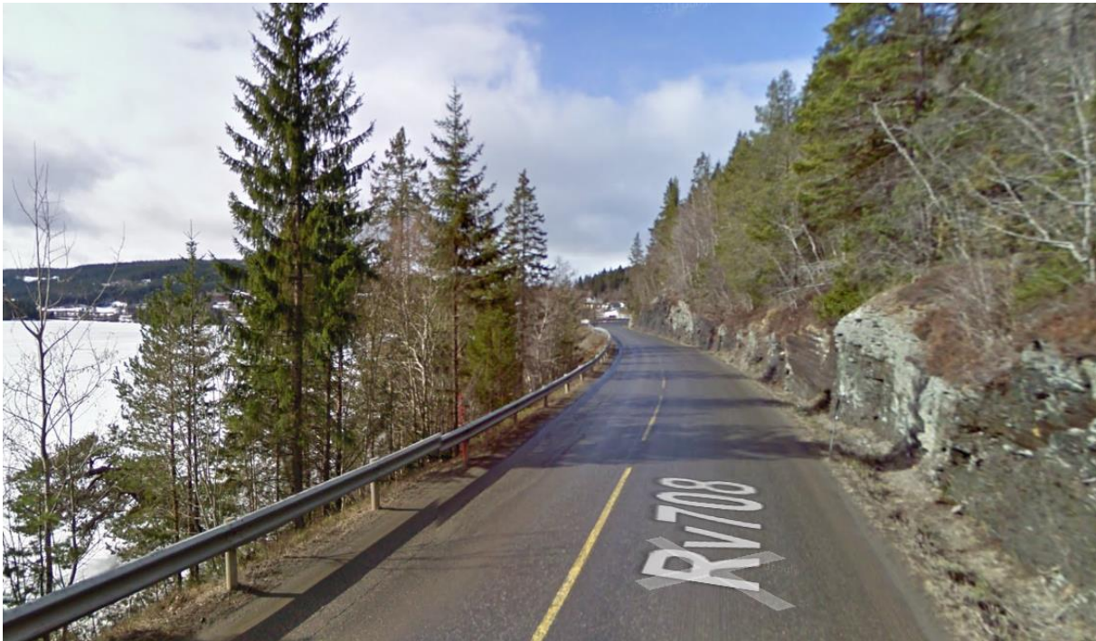
Figur 67: Viser Fv. 708 langs Ånøya i Melhus kommune. Det bor folk langs vegen på denne strekningen og fylkesvegen er den eneste forbindelsen mellom boligene. Vegbredden er mellom 6 og 7 m. Rekkverket som er nødvendig for å sikre de kjørende, gjør at det blir enda vanskeligere for myke trafikanter å benytte sideterrenget når de møter større kjøretøy (Kilde: Google maps).
