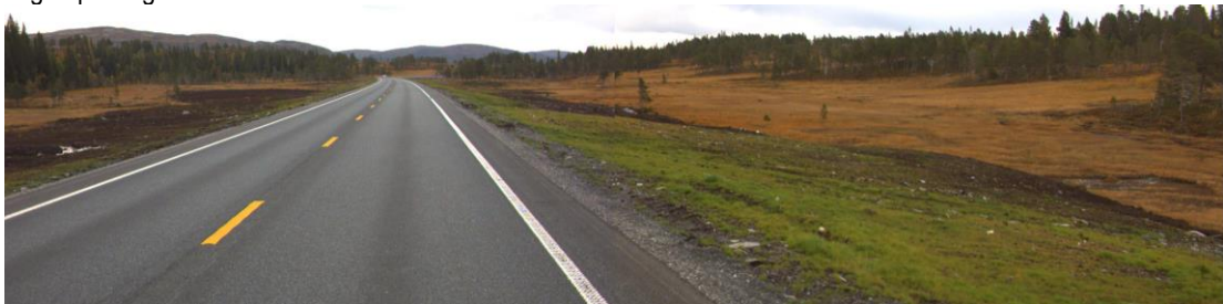
Figur 39: Viser pent utslakede skråninger på strekningen iht. merknad. Her ser en fra ca. profil 14000 i retning Harangen.
