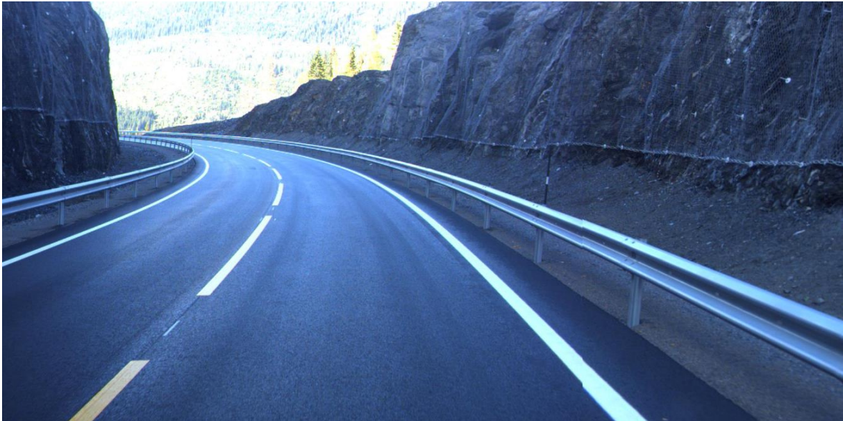
Figur 72: Fv. 715 på Fosen, viser et eksempel på tosidig skjæring med rekkverk. Dette anlegget ble bygget i 2015.
