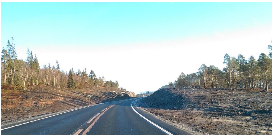
Figur 46: Jordskjæringer i ca. profil 13500.
