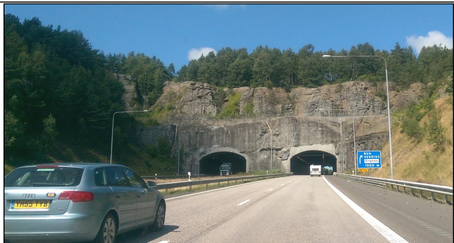
Figur 19: Bildet er tatt på E20/E6 (Sverige) i retning Gøteborg, ved avkjøring til Veddige. Portalområdet er et synlig terrenginngrep som ikke er bearbejdet.
