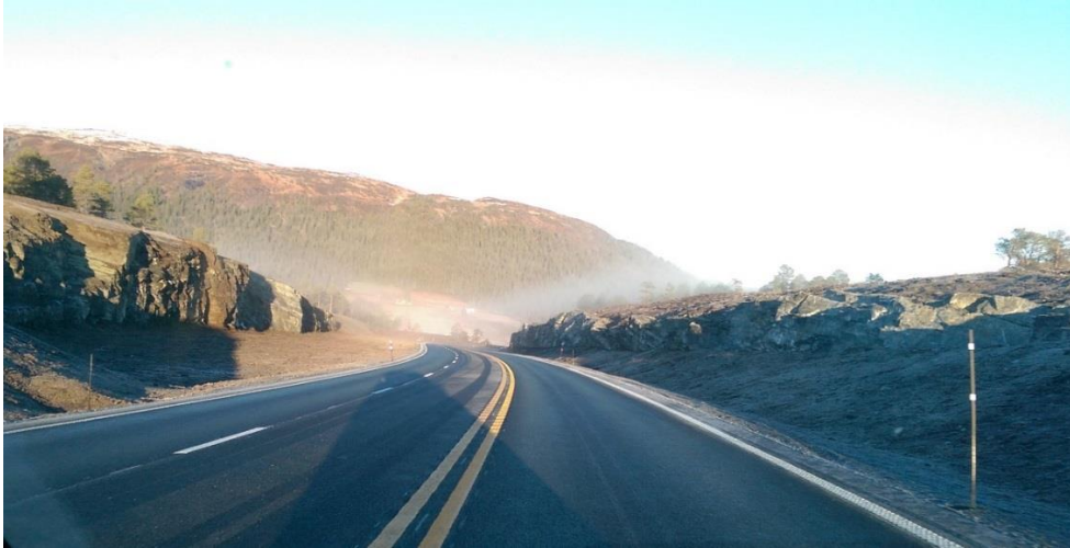
Figur 47: Viser tosidig fjellskjæring i ca. profil 11000, mot Harangen.
