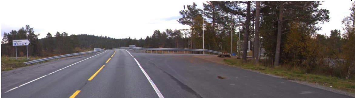
Figur 37: Bildet er fra ca. profil 15220 i retning Harangen. (Kilde: NVDB)
