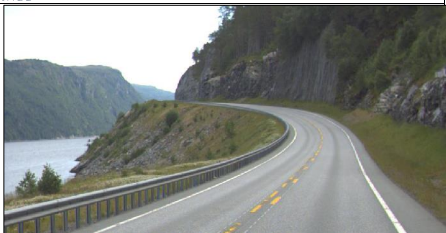
Figur 22: Bilde fra E39 mellom Engdalen og Vinjeøra (langs Vinjefjorden). Veg bygget på fylling i Vinjefjorden. Terrenginngrepet (høye bergskjæringer) er også veldig synlige i landskapet. Kilde: NVDB
