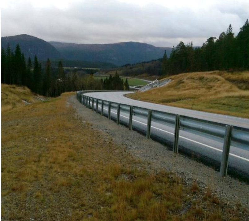
Figur 55: Viser at kurvaturen på vegen er fint tilpasset terrenget/omgivelsene. Bildet er tatt i ca. profil 26050 i retning Krokstadøra.
