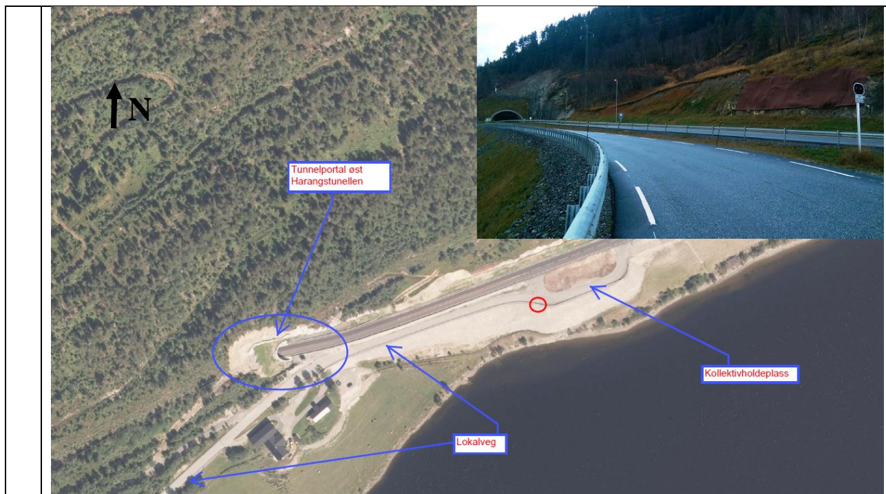
Figur 31: Ortofoto (nederst) viser en oversikt over portalområdet ved Harangstunellen-Øst (forskjæring). Av samme oversikt ser man at fyllingene på sørsiden av veien går helt ned mot Gangåsvatnet. Bildet (øverst til høyre) er tatt fra lokalvegen sør for E39 mot forskjæringa, rød sirkel viser fotografens plassering (Kilde: NVDB).
