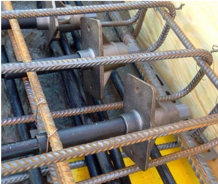
Figur 3-1 Passive ankere, klare for støp.
