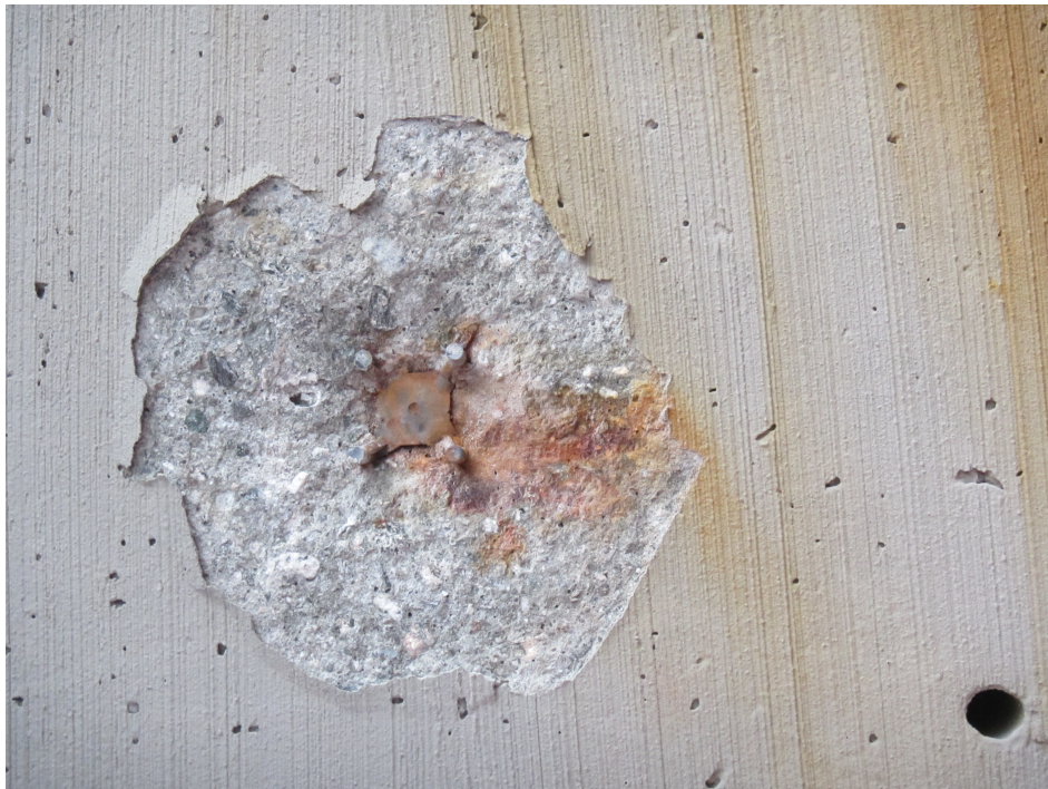
Figur 4.8: Bom på tverrbærer, men ukjent plassering
