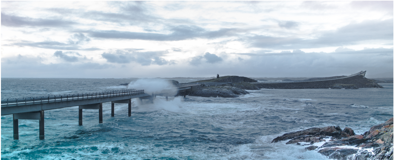
Figur 4.3: Storm på Hulvågbrua
