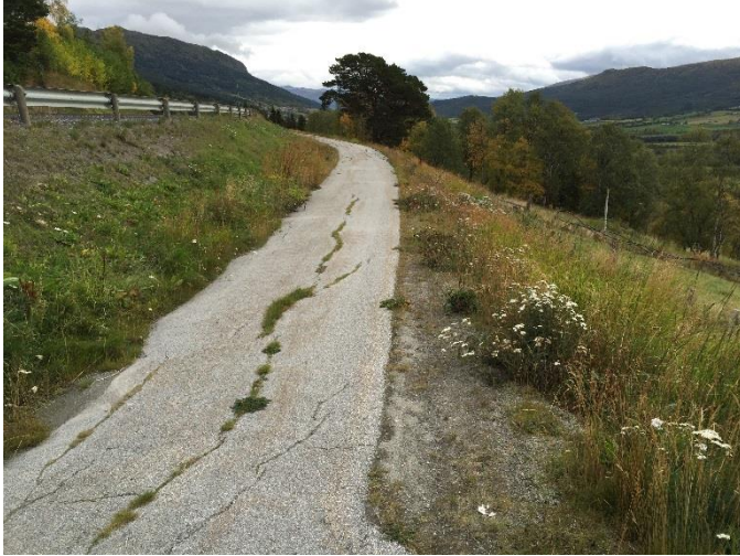
Bilde 18 Bø - Hole. Grunn grøft, vegetasjon. Av Eigil Andersen 22.09.15
