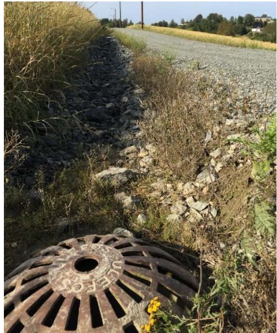
Bilde 8 Grøft og sandfang. Av Eigil Andersen 10.09.15
