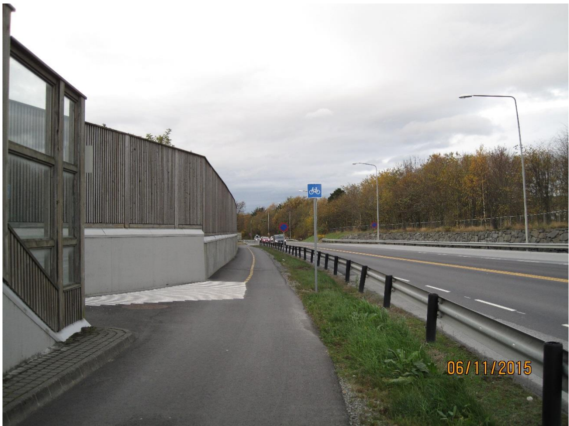
Figur 10: Fv. 510 Diagonalen sett mot nord-vest
