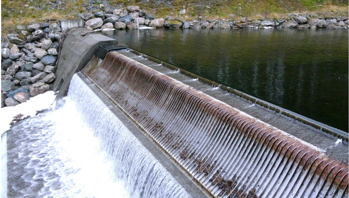
Figur 1 Coandainntaket på Dyrkorn. Snorkelen er plassert helt til høyre på inntaket.
