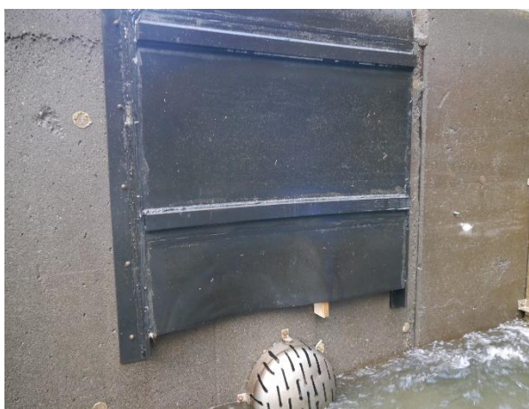
Figur 21 Fortsatt tydelig deformasjon etter montering av en trekloss.
