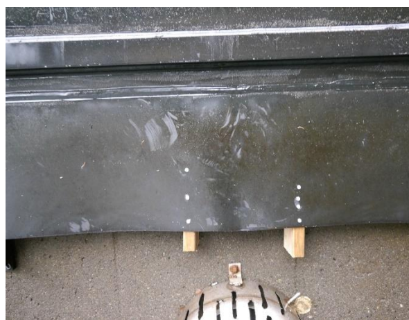
Figur 22 Her er deformasjonen ferdig utbedret, men fortsatt er innløpet ujevnt.
