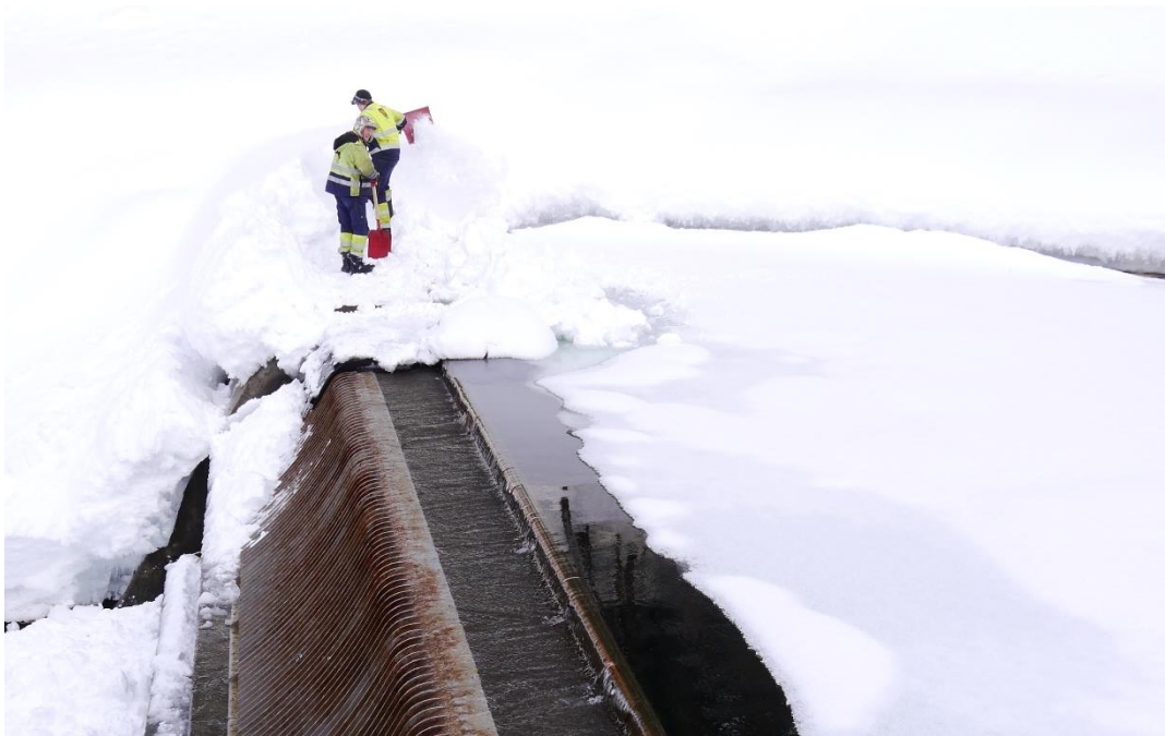
Figur 16 Snorkelen ligger her under snø og isen har lagt seg inntil snorkelen hvor hastigheten er lav. Det er åpen råk inntil dammen og langs land på høyre side.
