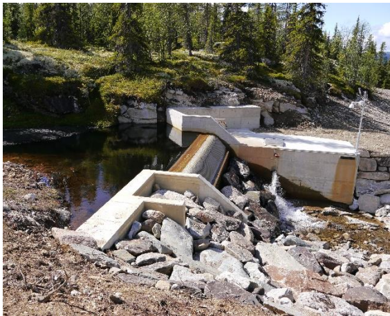
Figur 4 Inntaket til Nybuelve kraftverk
