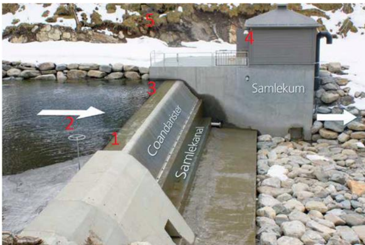
Figur 14 Plassering av utstyr på Dyrkorn: 1 – snorkel. 2 – SWIPS, temperaturlogger og trykklogger. 3 – temperaturlogger like under overflaten. 4 – viltkamera, trykklogger og webkamera. 5 – viltkamera. (Brødrene Dahl, u.d., s. 3)
