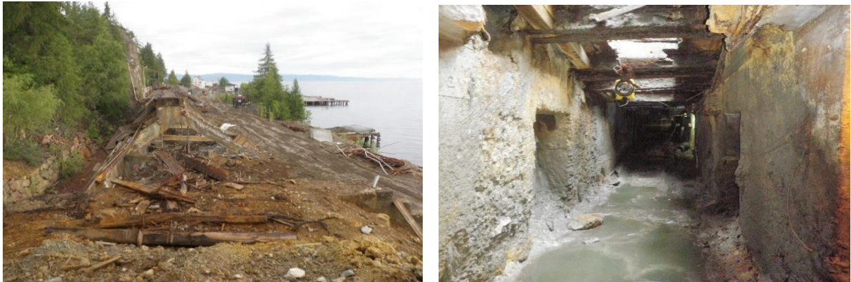
Figur 2-3. Bilder fra oppryddingen. Til venstre: Lagerhallen i forgrunnen med lossesjakter i nord. Til høyre: Transporttunnelen med lossesjakter over (Multiconsult 2011).
