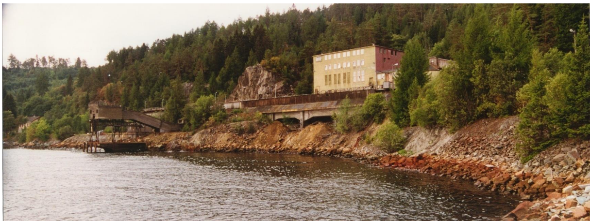
Figur 1-1. Killingdal Grubers anlegg sett fra nord. Til venstre synes utskipningskaien. Det gule bygget til høyre er oppredningsverket. Mellom sjøen og bygget var det lossesjakter og lagerhall for malmen. Merk at sjøkanten er sterk misfarget på grunn av forurensning. (Multiconsult).
