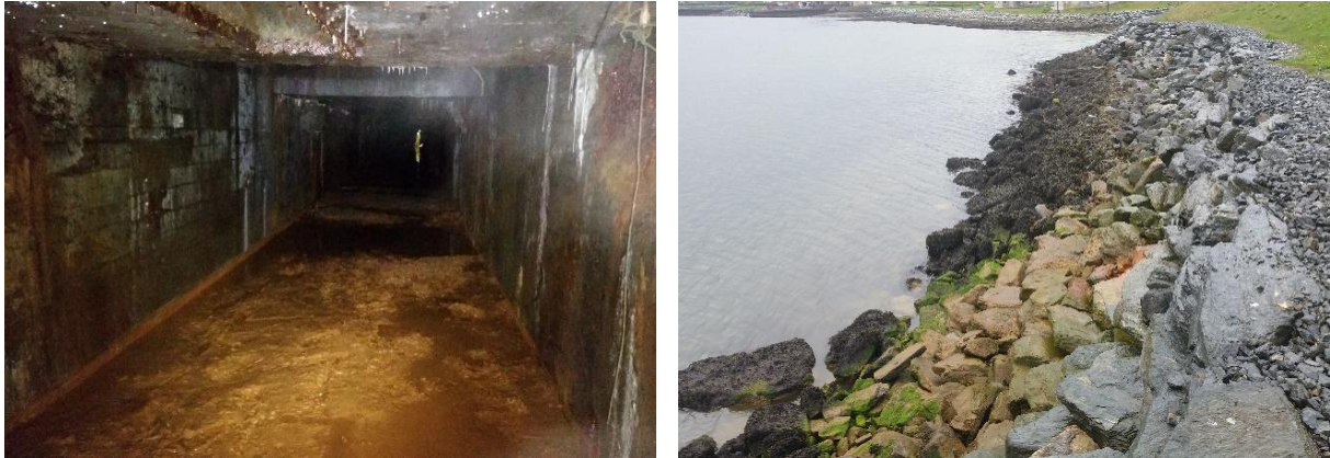
Figur 2-7. Bilder av området i 2015, fem år etter oppryddingen. Til venstre: Tydelig rustfarge på vannet og grusen inne i transporttunnelen (21.05.15). Til høyre: Utfellinger på steiner ved prøvepunkt V4. Bildet er tatt under fjære. (22.05.2015) (Rambøll).
