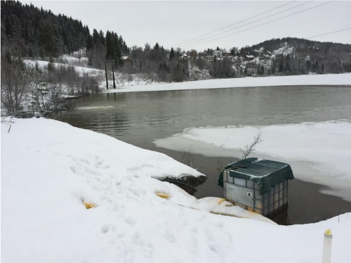
Figur 2-11. Pilotrenseanlegg med olivingranulat var Bjørnlivann på Løkken. Grunnvann pumpes inn i bunnen av tanken med olivingranulat og renner ut på toppen. Bildet er tatt 7.12.16 (Jørgen Engebretsen).
