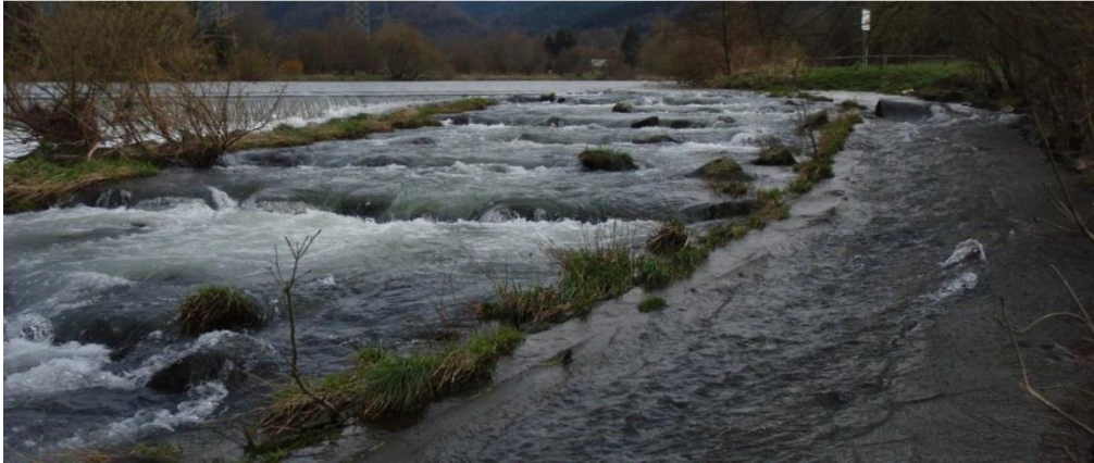
Figur 11. Naturlik bassängtrappa vid kraftverket Unkelmühle i vattendraget Sieg i Tyskland. Foto: Olle Calles. (Calles O. 2012).
