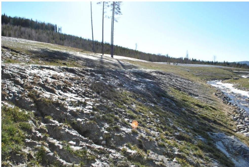
Figur 20. En stor yta runt omløpet har blitt avverket hvilket kan leda till kraftigt ökad erosion. Foto: Författaren.
