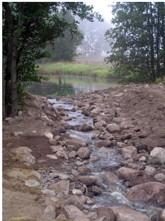
Figur 10. Upptröskling i Sjörödsbäcken, Hjo kommun. Fotot är taget under konstruktion. (degerman E. 2008).
