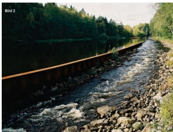
Figur 12. Ett naturliknande inlöp vid Hemsjö nedre i Mörrumsån. Foto: Arne Johlander. (Risinger B. 2014).
