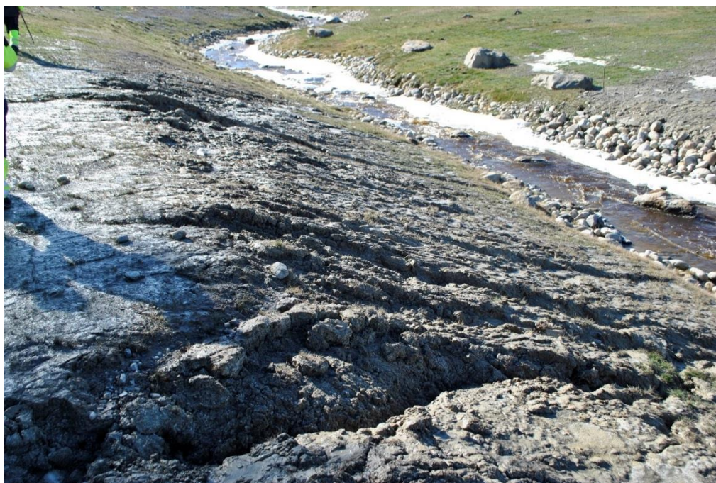
Figur 21. Runt större delen av omløpet kunde erosion av kanterna observerats. På bilden syns ett av de värst drabbade ställerna. Foto: Författaren.
