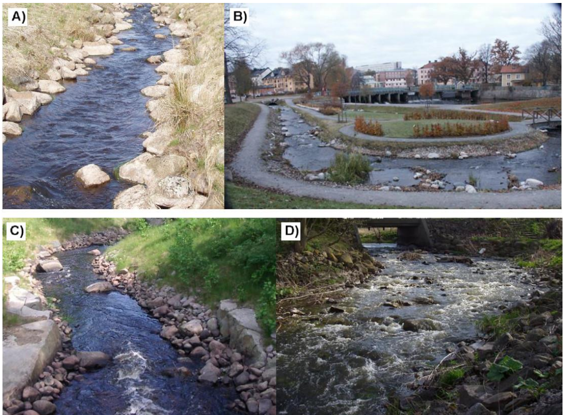
Figur 13. Exempel på omlöp. A) & C) Emån, B) Svartån och D) naturlig fåra av överlöpstyp i Västra Götaland. Foto: A) & C) Olle Calles, B) Erik Degerman, D) Länsstyrelsen i Västra Götalands Län. (Calles O. 2012).
