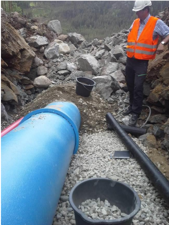
Figur 31: Masseprøver henta fra Nybuelve kraftverk
