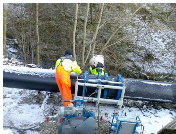
Figur 8: Hydraulisk rigg for buttsveising av PE-rør (Hordaland Rørteknikk AS)
