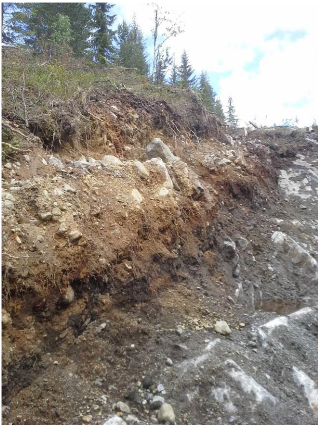
Figur 22: Eksempel på grøfteprofil ca 350 meter oppfor Tverråne kraftverk.: Humuslag på toppen, noe morenejord i varierende tykkelse og til dels kort vei ned på fjell. Ved god planlegging er det mulighet for å ta vare på morenelaget før boring og sprening. (Foto: Tor Oxhøvd Svalesen)
