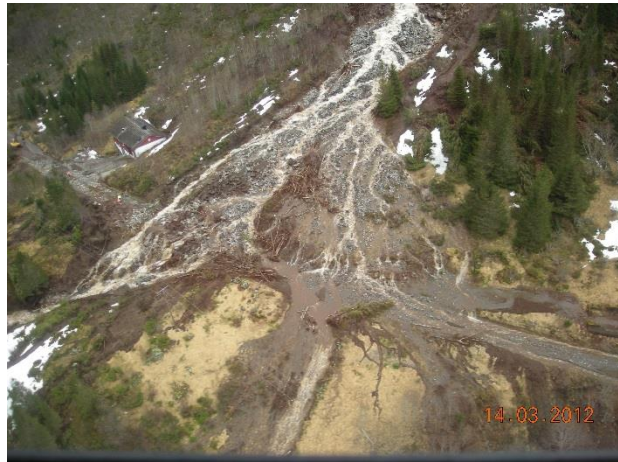
Figur 40: Flyfoto tatt nedstrøms bruddstedet som viser omfanget av skadene elva har påført terrenget. Kraftstasjonen oppe i venstre hjørne. Foto: Sykkylven Energi AS
