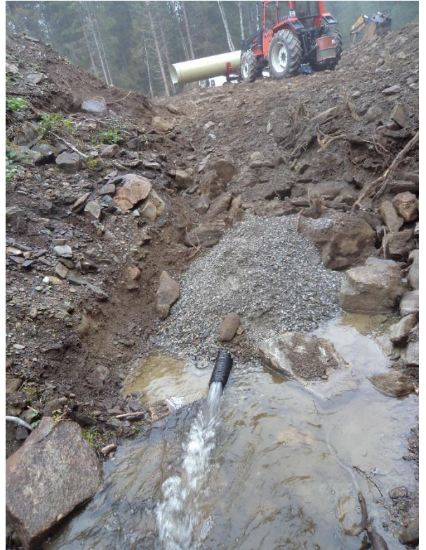
Figur 15: 110 mm drenerør som går fullt etter bekketryssing. Foto: Tor Oxhovd Svalesen
