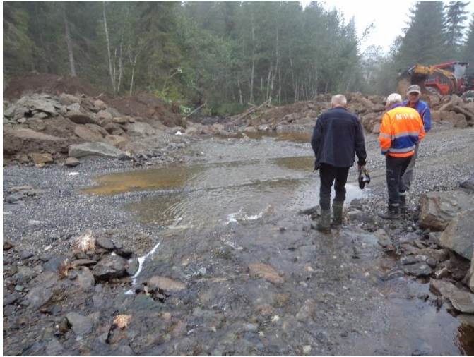
Figur 14: Bekkekryssing Sundli Kraftverk, foto: Tor Oxhovd Svalesen
