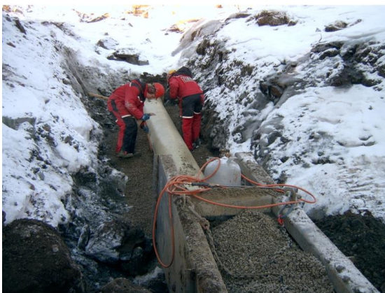
Figur 6: Bruk av omfyllingskasse, eksempelbilde. Kilde: Ragnar Hartmann
