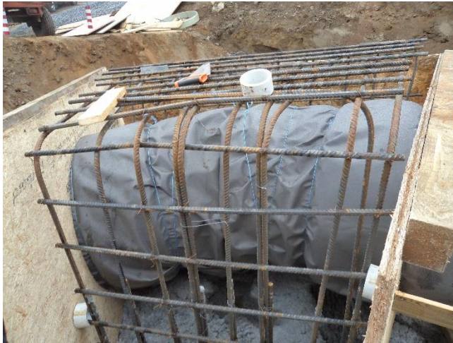
Figur 18: Armering av bend B7 (30°). Inn mot røret er det lagt en duk som skal hindre at betongen hefter direkte i GRP-materialet. Foto: Tor Oxhøvd Svalesen
