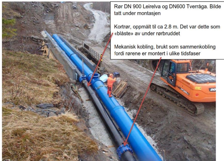
Figur 20 Kryssing av Tverråga under bygging. Kortrør DN600 "blåste" ut under rørbrytet. Kilde Norconsult/Norsk Grønnkraft stabilitet.
