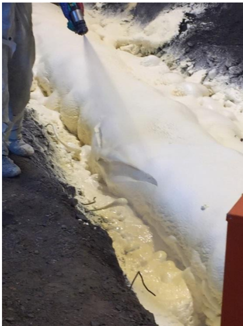
Figur 57: Påføring av PU, forsøk Mjøndalen. (Foto: Penstock BV)
