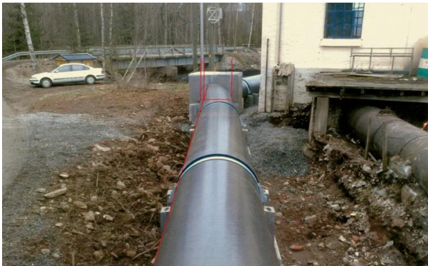
Figur 3: Forskjøvet forankringskloss. Røde linjer indikerer forskyvninga av klossen.
