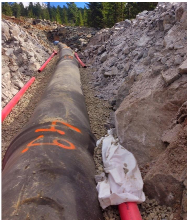
Figur 25: Legging av rørgate Tverråga, overgang fra strekkfaste til ikke strekkfaste (blå rør). (Foto: Norsk Grønnkraft AS)
