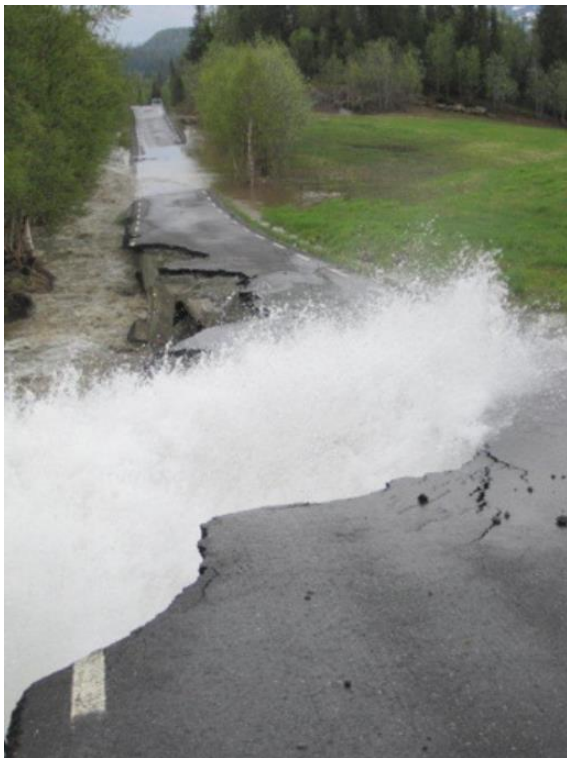
Figur 10 Brudd ved Gåsvasselva kraftverk, ukontrollert utstrømming av vann mot fylkesveien. Foto: Statkraft
