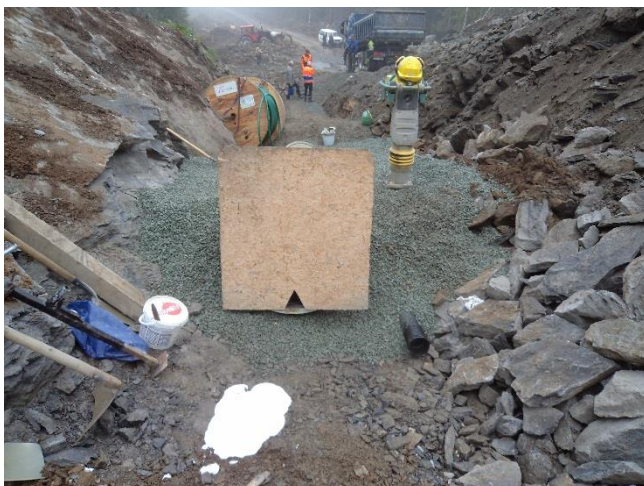
Figur 13: Typisk grøftetversnitt for GRP-prosjektet med 8-16 mm pukkk 2/3 opp på røret. Foto: Tor Oxhovd Svalesen
