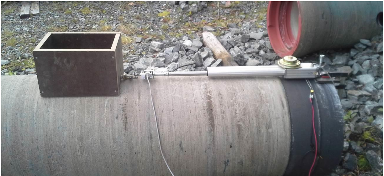
Figur 45: Sylinder og kasse montert på sementmørtelbetong-rør
