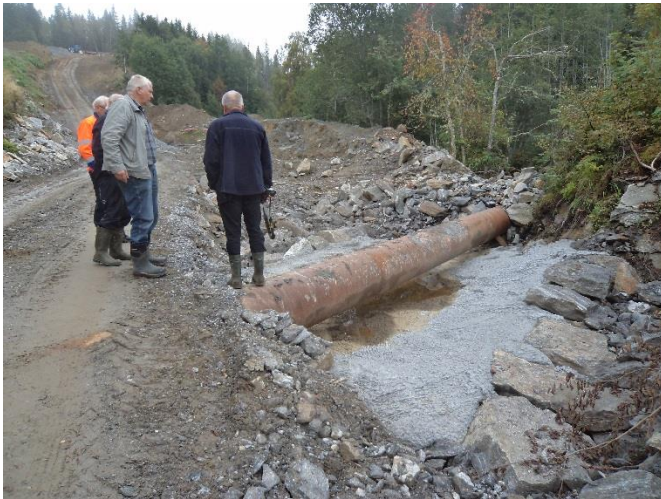
Figur 15: 110 mm drenerør som går fullt etter bekketryssing. Foto: Tor Oxhovd Svalesen
