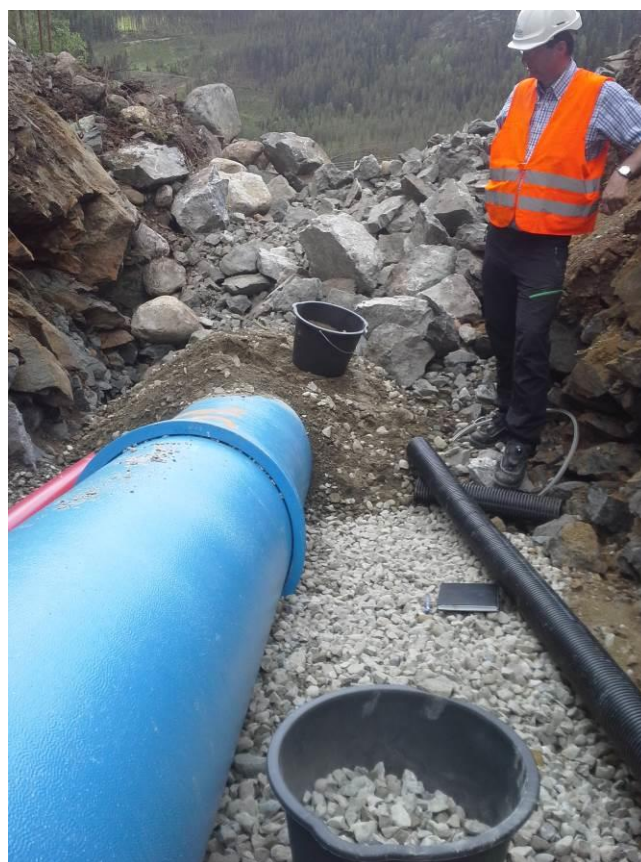
Figur 27: Nybuelve kraftverk, legging av duktile støpejernsrør. Masseprøvene M3 og M7 er tatt fra omfyllingsmassene på bildet (Foto: Tor Oxhøvd Svalesen)
