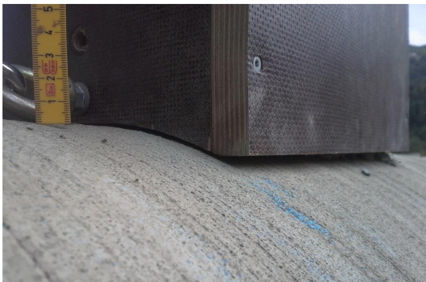
Figur 55:Kasse mot rør med sementmørtelbetong
