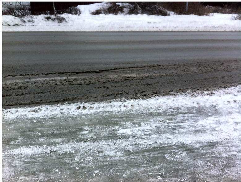
Figur 4.2: Synlige forurensninger i snø og slaps på vei. Foto: Svein Erik Helland Grønvold.
