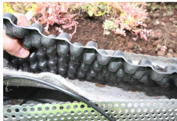
Figur 15: Oppbygning av takrute C
