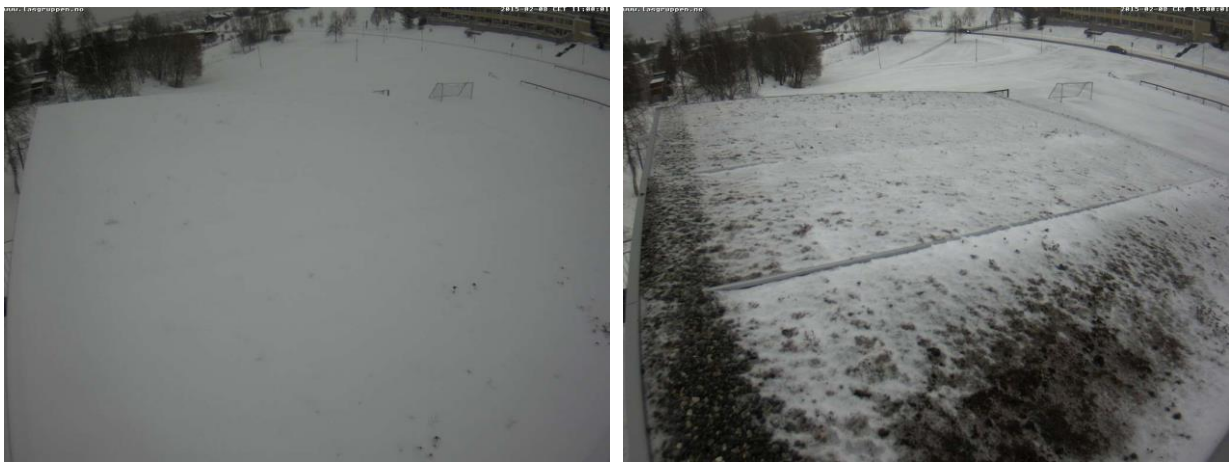
Figur 40: a) Snømengde på taket før snøsmelting og b) snømengde etter snøsmelting
