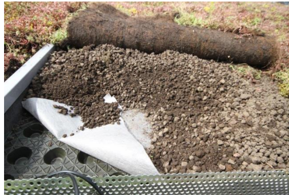
Figur 16: Oppbygning av takrute D
