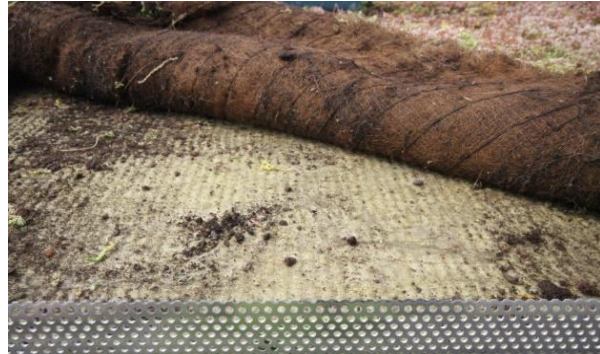
Figur 14: Oppbygning av takrute B
