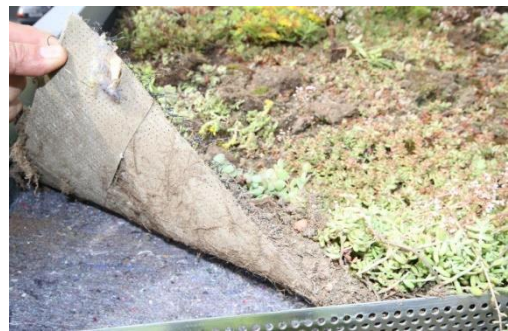
Figur 13: Oppbygning av takrute A
