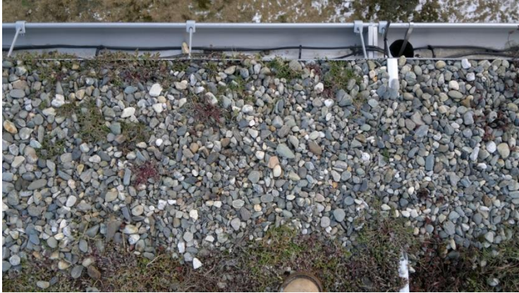
Figur 11: Dreneringsstein for vindsikring av takmattene
