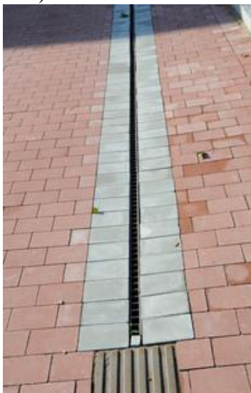
Figur 13: Eksempel på norsk slisserenne (Skjæveland Cementstøperi, 2014)
