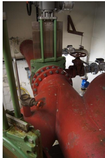
Figur 45 Ventil for trykkmåler på Lillegata (Foto VN)
