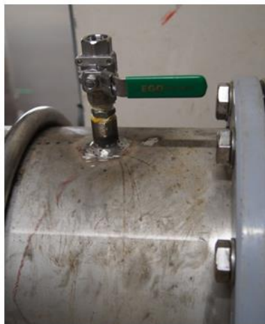
Kuleventil ferdig montert
