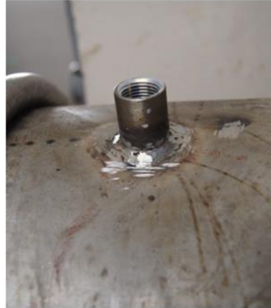
Gjengesylinder sveiset fast til hovedtrykkledningen
