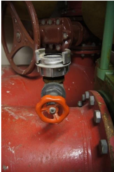
Figur 46 Ventil for trykkmåler IISVIKØRA (Foto VN)
