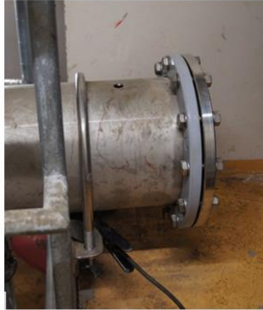
Boring av ledningen
