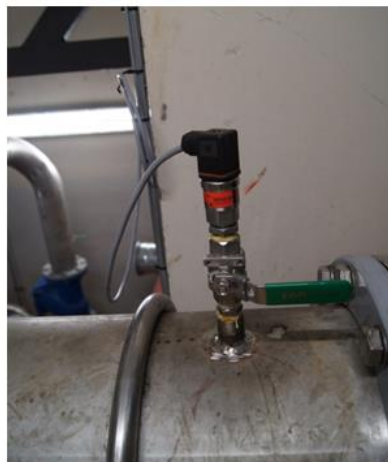
Trykkmåler ferdig montert med oppkobling til PLS
