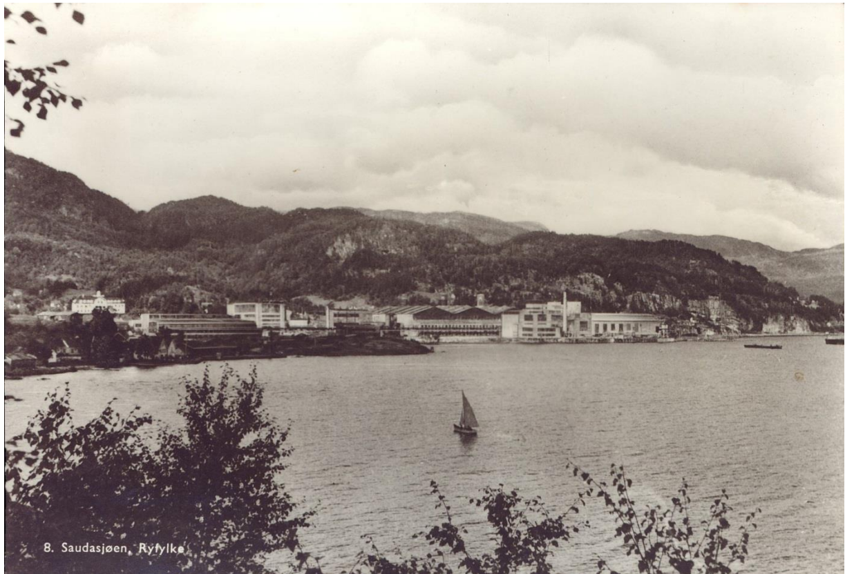
Bilde 5: Viser den tilnærmet ferdige oksidfabrikken i Saudasjøen.
