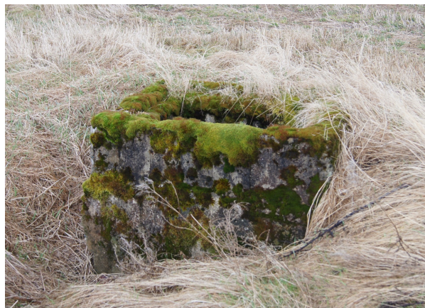
(a) Brønn i leir 4, pr. 27.02.2012. Retning NØ.
