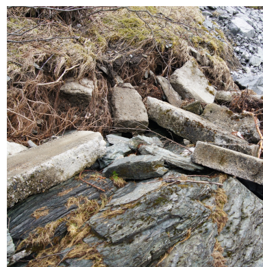
(c) Betongbitar. Funne ved fjorden. Retning SØ.
