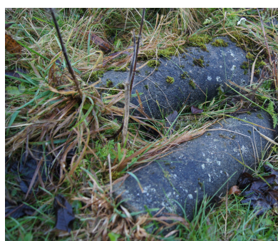
(a) Betongrør. Retning N.
