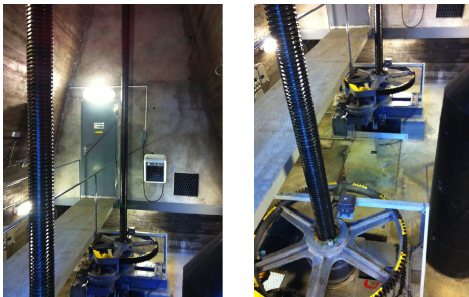
Figur 1.5: Bilder fra befaring i lukehuset på Homstøl.
