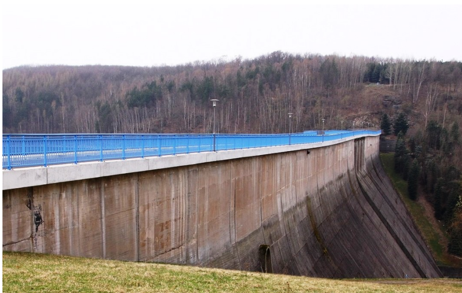
Figur 4.3: Nedstrøms side av dam Gottleuba sett fra høyre vederlag (Adam, 2014)
