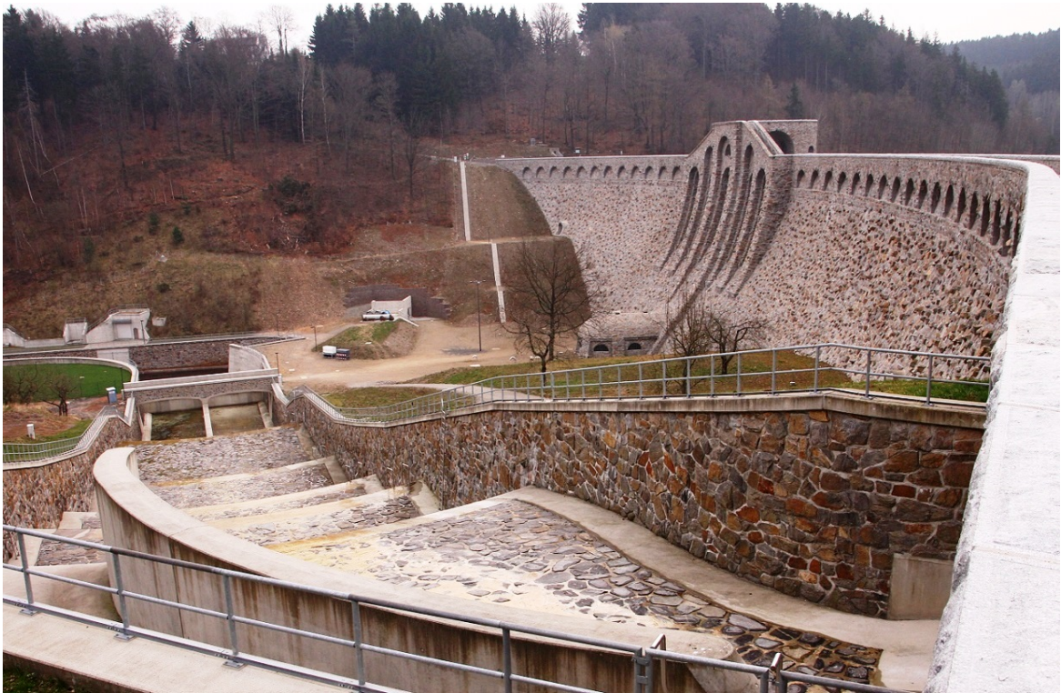
Figur 2.2: Nedstrøms side av dam Klingenberg sett fra venstre vederlag (Adam, 2014)
