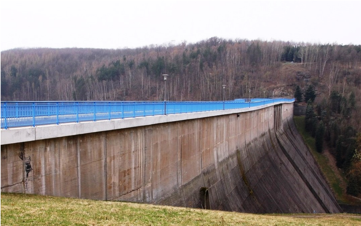
Figur 3.5: Nedstrøms side av dam Gottleuba sett fra høyre vederlag (Adam, 2014)
