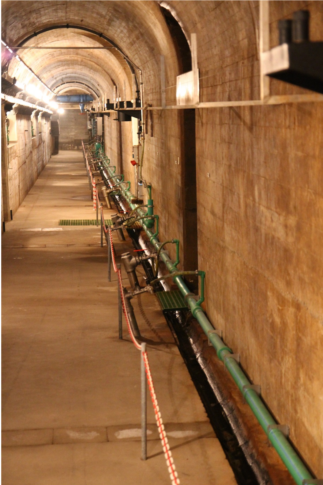
Figur 3.8: Inspeksjonsgang med drenasjesystem (Adam, 2014)
