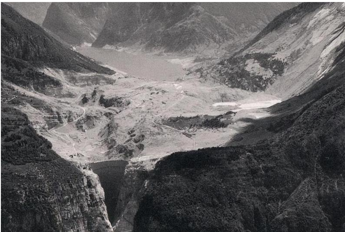
Figur 1-1: Vajontmagasinet etter skredet. Arr fra skredet kan sees til høyre, mens trelinjen på venstre side indikerer bølgeoppskyllingen (Petley, 2008).
