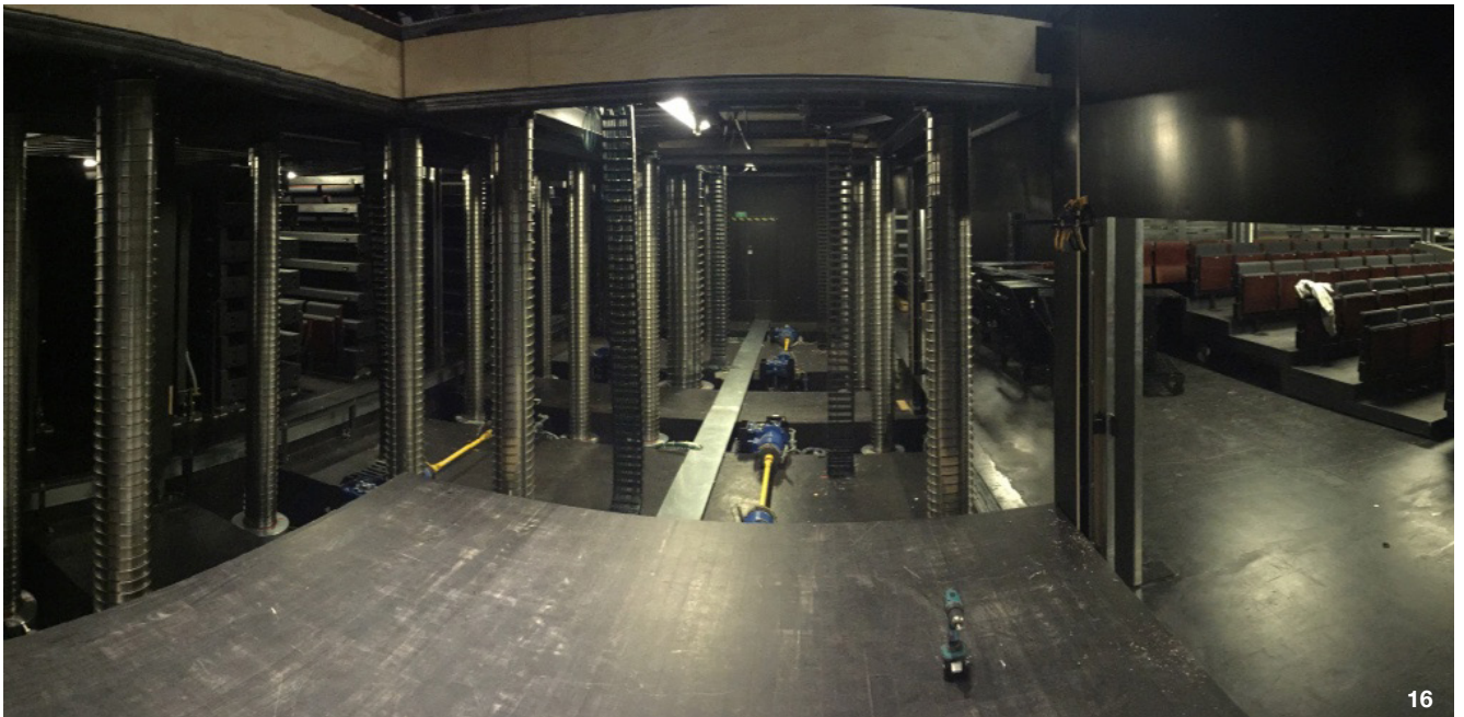
13. Nødutgang fra orkestergrav 14. og 16. Heving og senking av scenen 15. Flerbrukssalen sett fra publikum
