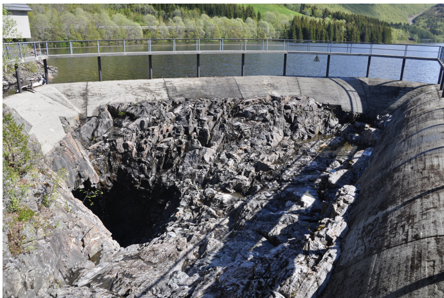
Figur 1.3: Terskel og innløp til sjakt slik det er i dag
