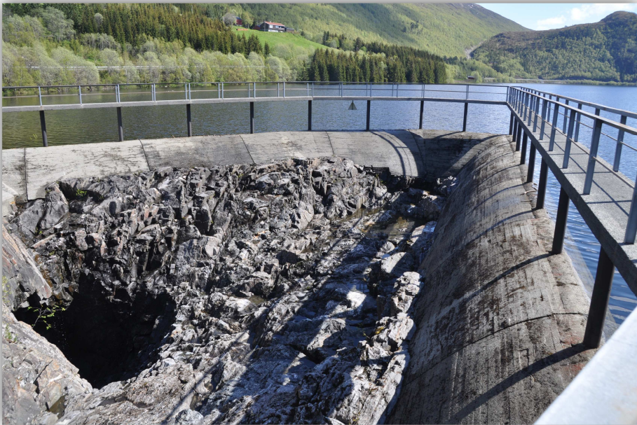
4. Samlekanalen og overløpsterskelen sett fra land
