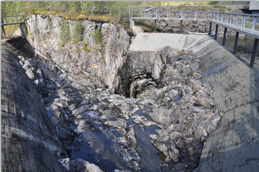
2. Samlekanalen sett fra ytterst i spissen
