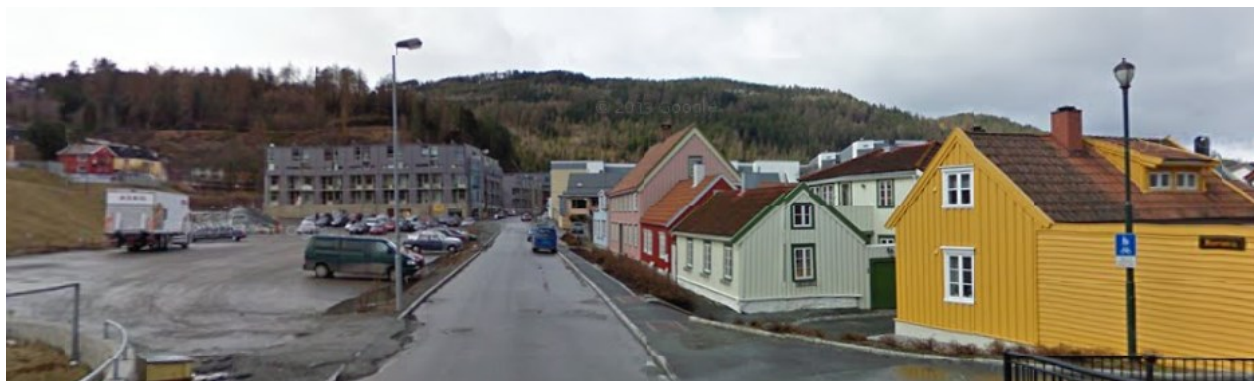
Figur 3: Eksisterende situasjon i Mellomila, sett fra øst (Google street view). Planområdet er parkeringsplassen til venstre for Mellomila.
