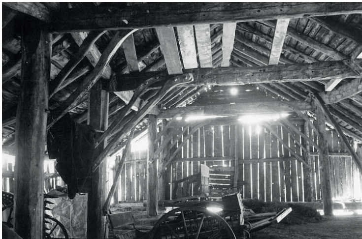
Stavløe i Os. Foto: Per Gjærder
