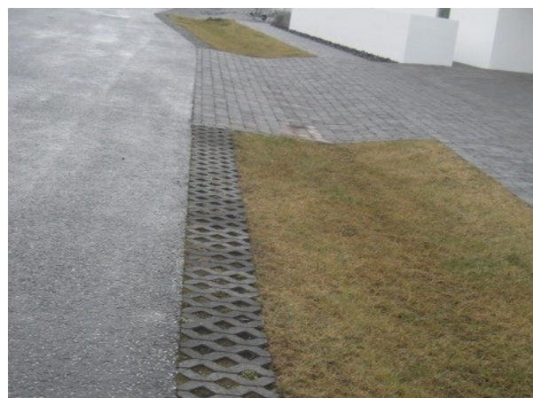
Figur 67 Forsterking av kanter med belegningsstein. Foto: Tore Leland
