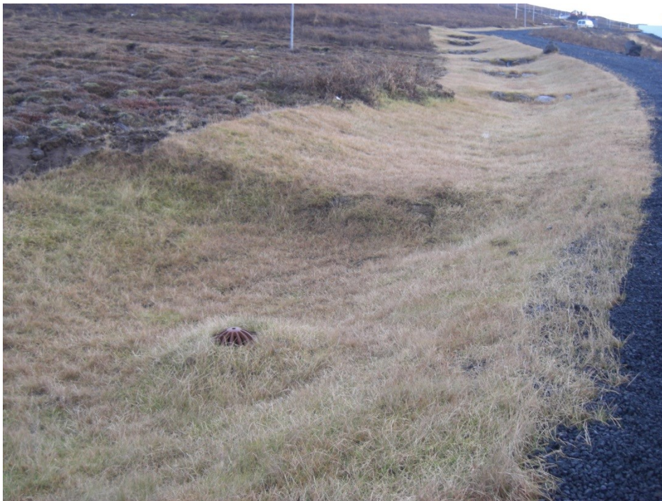
Figur 40 Kuppelrist hevet over grøftebunnen. Foto: Tore Leland
