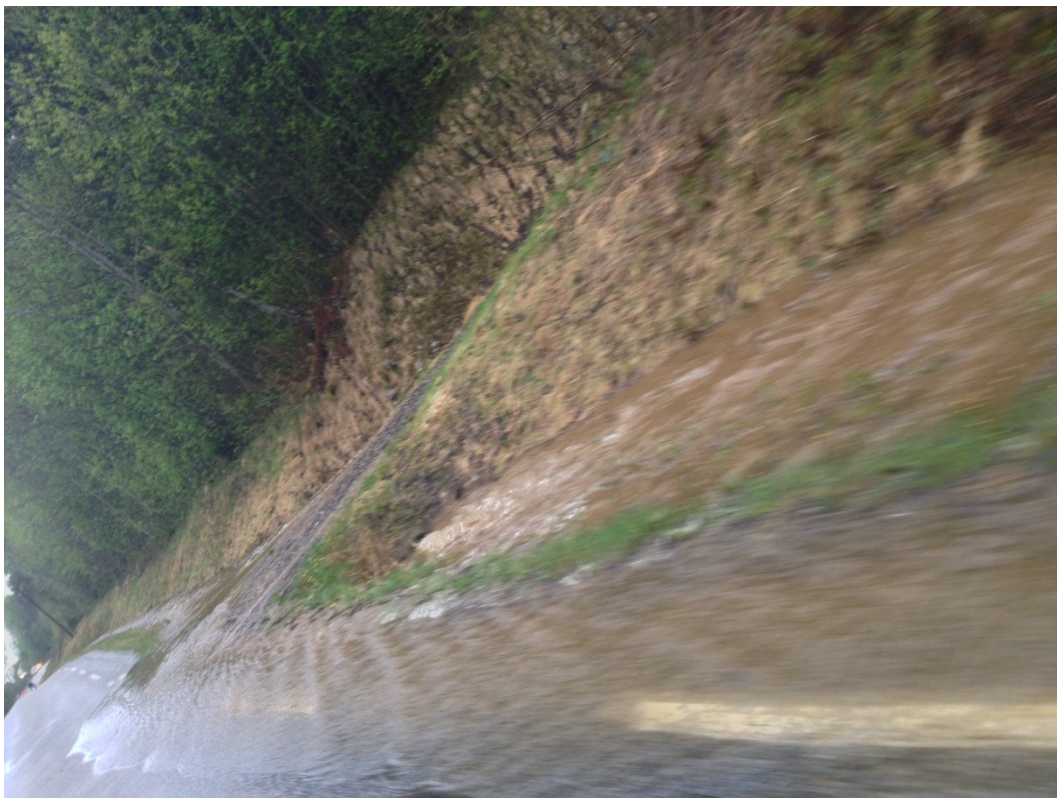
Figur 44 Stikkrenner er et kritisk punkt. Dersom den hydrauliske kapasiteten ikke er tilstrekkelig kan det oppstå oppstuvning og oversvømmelse. Foto: Tore Leland
