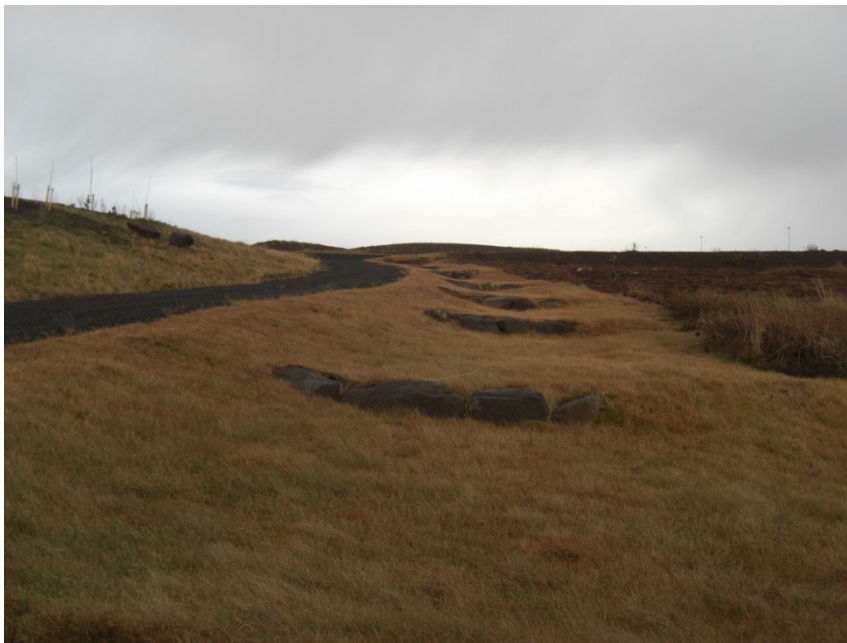
Figur 61 Trappefall kan også brukes for å redusere hastigheten i bratt terreng. Foto: Tore Leland
