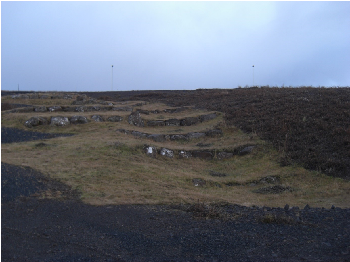
Figur 88 Trappefall reduserer hastigheten i bratte partier. Foto: Tore Leland
