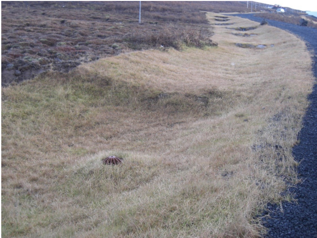
Figur 66 Kuppelrist hevet over grøftebunnen. Foto: Tore Leland
