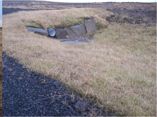
Figur 80 Erosjonsikring av konsentrert innløp med steinlegging. Urridaholt, Island
