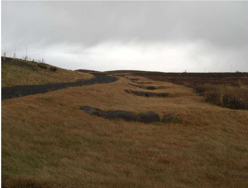
Figur 35 Trappfall kan også brukes for å redusere hastigheten i bratt terreng. Foto: Tore Leland
