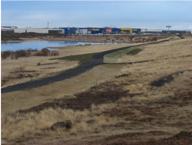
Figur 81 "Avskjærende" gresskledd forsenking mellom Urridavatn og bebyggelsen på Urridaholt fordrøyer og
