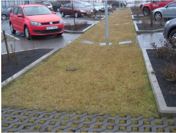
Figur 84 Ettermontering av gresskledd forsenking på en parkeringsplass i Reykjavik. Foto: Tore Leland
