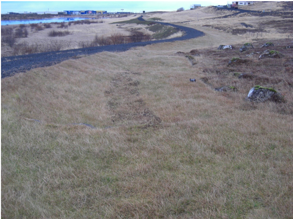
Figur 86 Gresskledd vannveg på Urridaholt, Island, reduserer og jevner ut avrenningen fra et boligområde. Foto: Tore Leland
