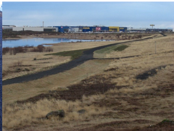
Figur 17 Avskjærende gresskledd vannveg er konstruert som en dam for å fordrøye overvann til det infiltrerer gjennom. Mellom vannvegen og innsjøen er det en våtmark. Foto: Tore Leland
