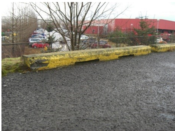
Figur 41 Kantstein med åpning i bunn. Foto: Tore Leland
