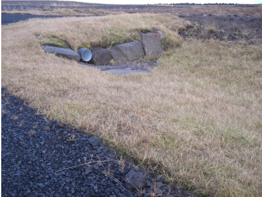
Figur 36 Erosjonsikring rundt stikkrenne med steiner. Foto: Tore Leland
