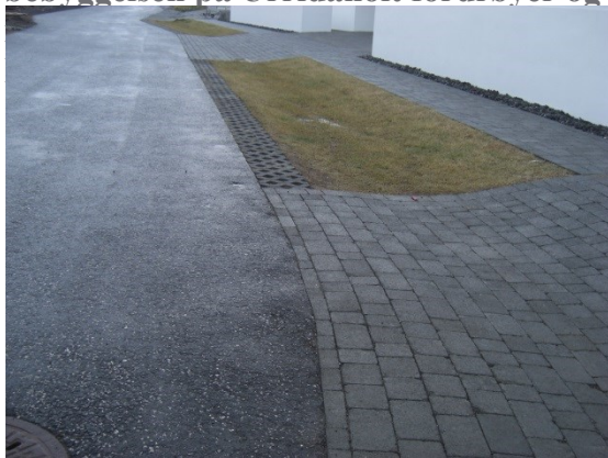
Figur 83 Gresskledd forsenkinger tåler ikke belastningen fra kjøretøyer. Her er kantene forsterket med belegningsstein. Urridaholt, Island. Foto: Tore Leland
