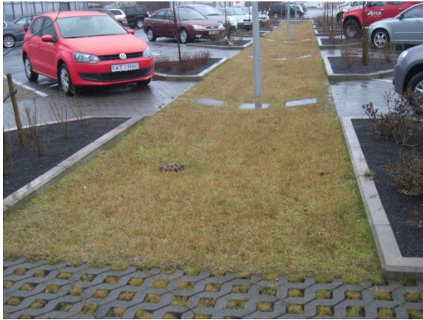
Figur 46 Ettermontering av en gresskledd vannveg på en parkeringsplass i Reykjavik, Reykjavik, Island. Foto: Tore Leland
