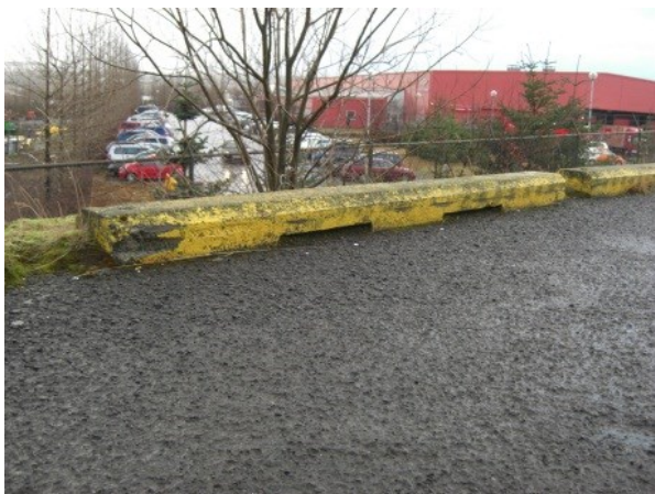
Figur 68 Kantstein med åpning i bunn. Foto: Tore Leland
