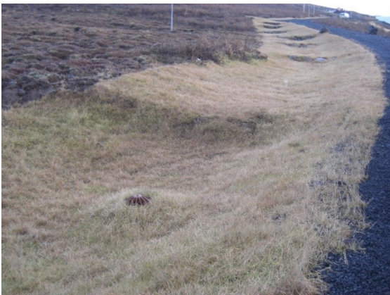
Figur 18 Utløp er hevet over bunnivået for fordrøye overvann til det rekker å infiltrere. Partier som er brattere enn 4% forseres med trappfall for å redusere hastigheten. Foto: Tore Leland
