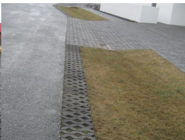
Figur 42 Forsterking av kanter med belegningsstein. Foto: Tore Leland
