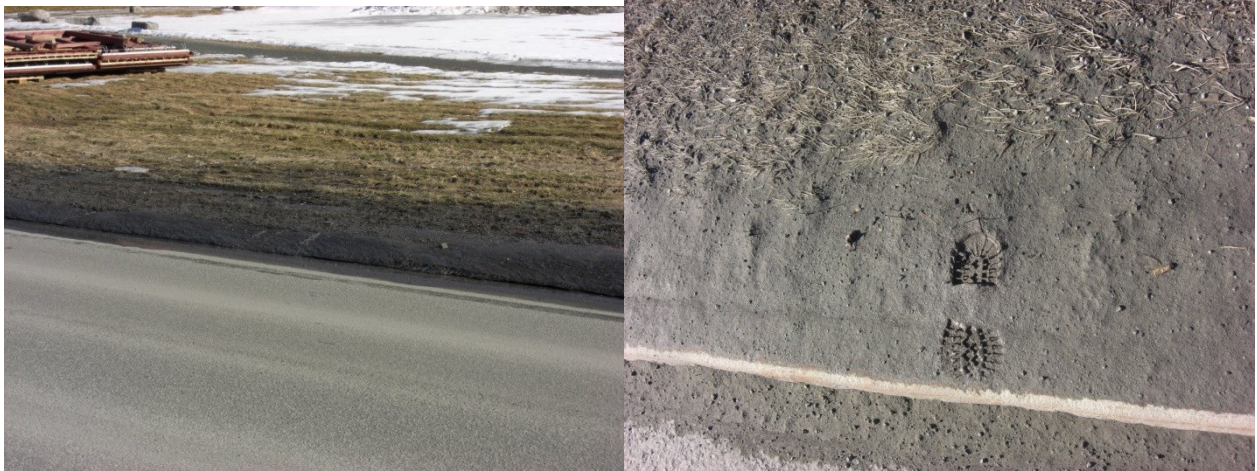
Figur 54 Sterkt forurenset snø, som brøytekanter langs veger, etterlater et tykt sedimentlag. Foto: Tore Leland
