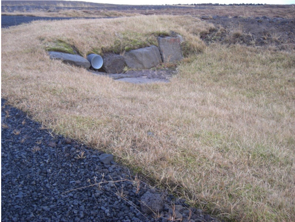
Figur 65 Erosjonssikring ved en stikkrenne med steiner. Foto: Tore Leland
