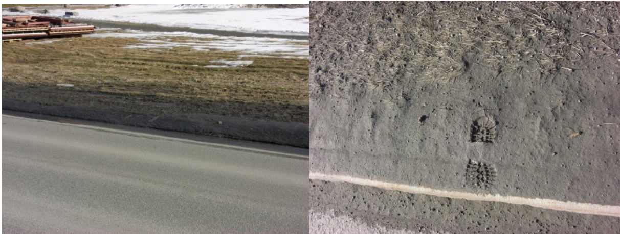
Figur 49 Sterkt forurenset snø, som brøytekanter langs veier, etterlater et tykt sedimentlag. Trondheim 30.03.2013 Foto: Tore Leland
