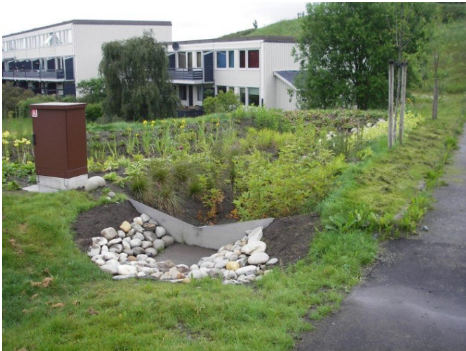
Figur 64 Utløpet til en gresskledd vannveg ender i et sedimenteringskammer for et regnbed på Risvollan. Foto: Arvid Ekle
