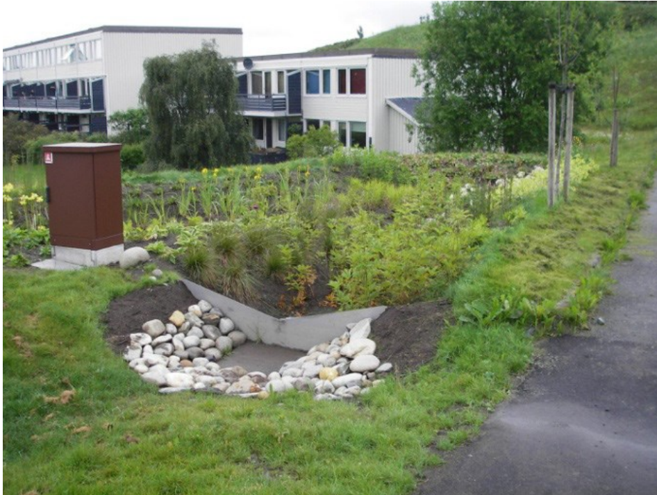
Figur 39 Utløpet til en gresskledd vannveg ender i et sedimenteringskammer for et regnbed på Risvollan. Foto: Arvid Ekle
