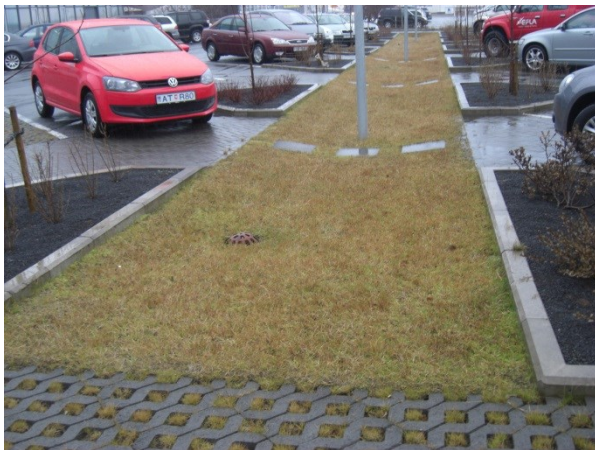
Figur 72 Ettermontering av en gresskledd vannveg på en parkeringsplass i Reykjavik, Reykjavik, Island. Foto: Tore Leland
