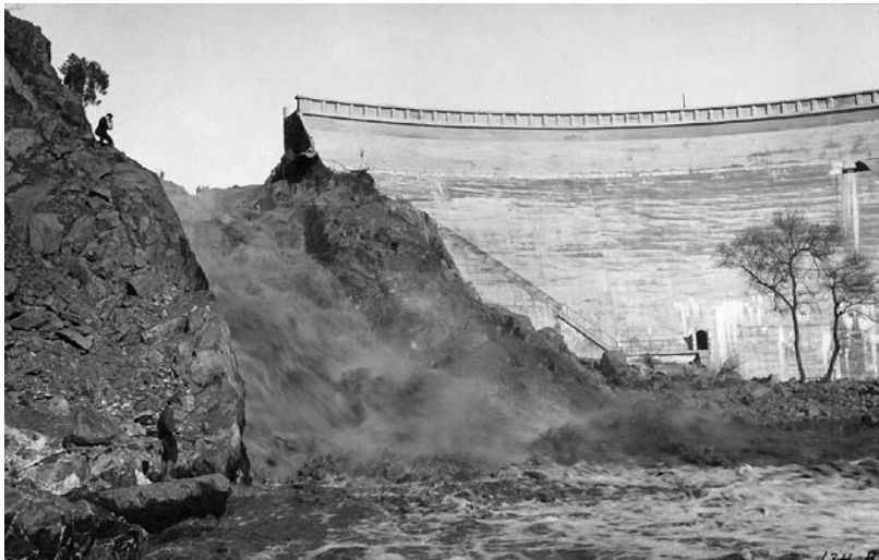
Figur 1 Brudd av vederlag i Sweetwater Dam (San Diego History, 2012)
