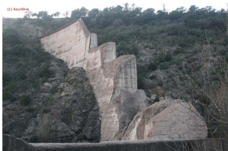
Figur 2 Brudd av Malpasset (Le Barrage de Malpasset, 2007)
